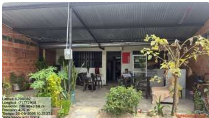
Vista general de la fachada y del corredor frontal cubierto de la vivienda.
