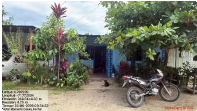
Vista general de la fachada, cubierta liviana y área frontal sin pavimentar.
