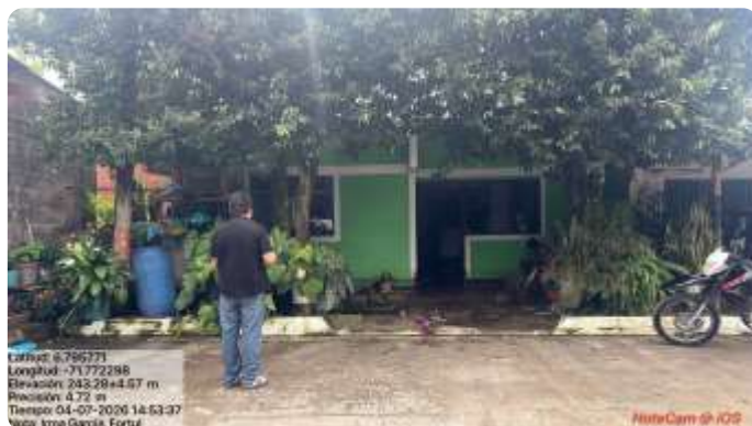
Vista general de la fachada y del entorno inmediato de la vivienda inspeccionada.
