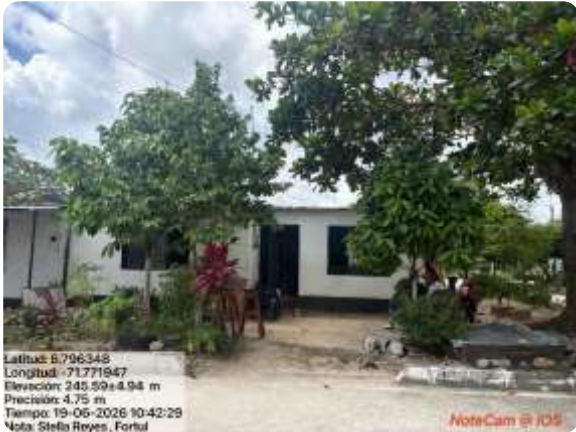
Vista general de la fachada y del entorno inmediato de la vivienda inspeccionada.
