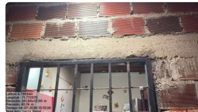
Bloque cerámico con modulación irregular, juntas variables y cambios de material en la franja sobre el vano.
