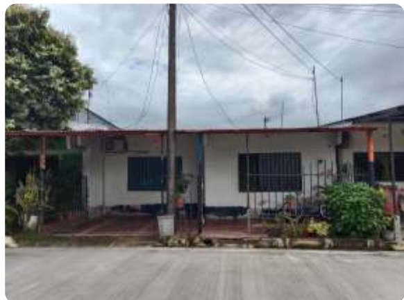
Vista general de una vivienda de un nivel con corredor frontal y cubierta liviana.
