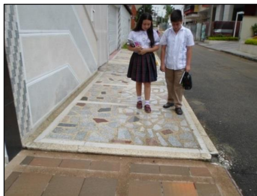
Figura 36. Andenes resbalosos por enchape inadecuado. Fuente: Propia.
