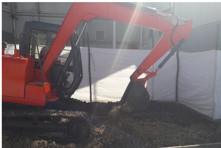
Ilustración 8. Retiro de capa superficial contaminada.
