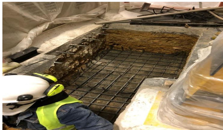
Ilustración 44. Solado de limpieza.
