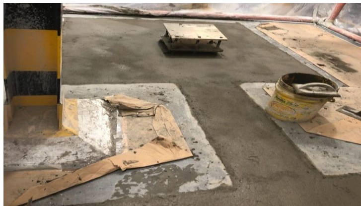
Ilustración 48. Acabado de cimentación.
