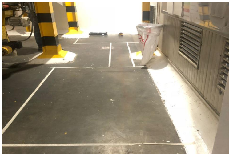
Ilustración 38. Localización y replanteo.
