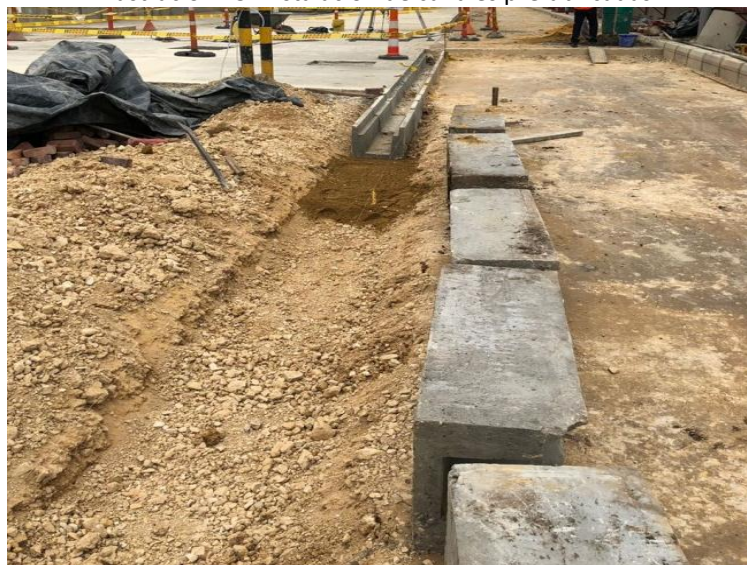
Ilustración 25. Instalación de canales prefabricadas.
