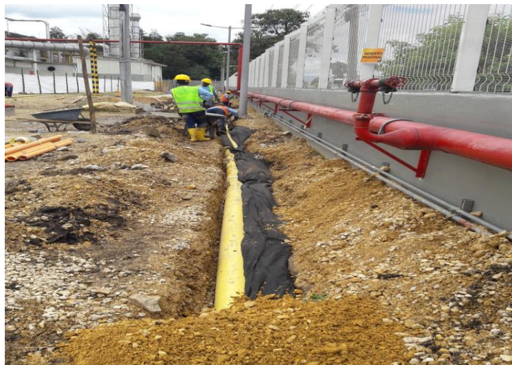
Ilustración 16. Cierre de geo textil después de instalar gravilla.
