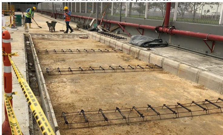
Ilustración 29. Instalación de pasadores.
