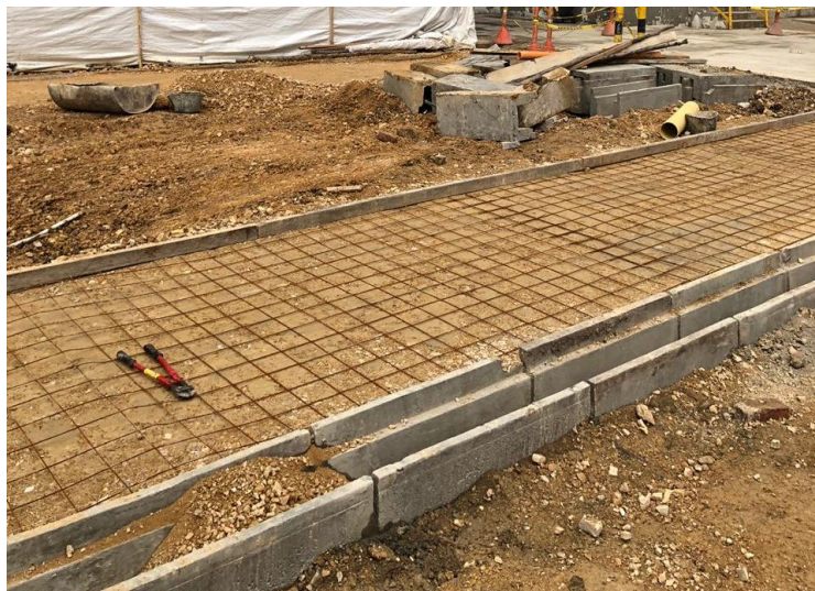
Ilustración 27. Instalación de malla electro soldada.
