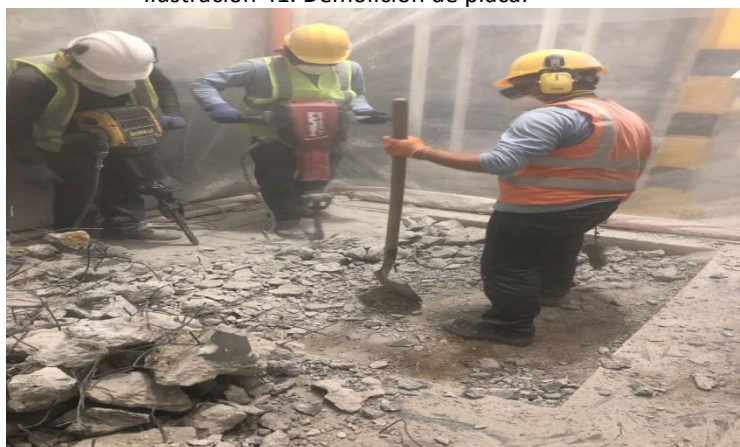
Ilustración 41. Demolición de placa.
