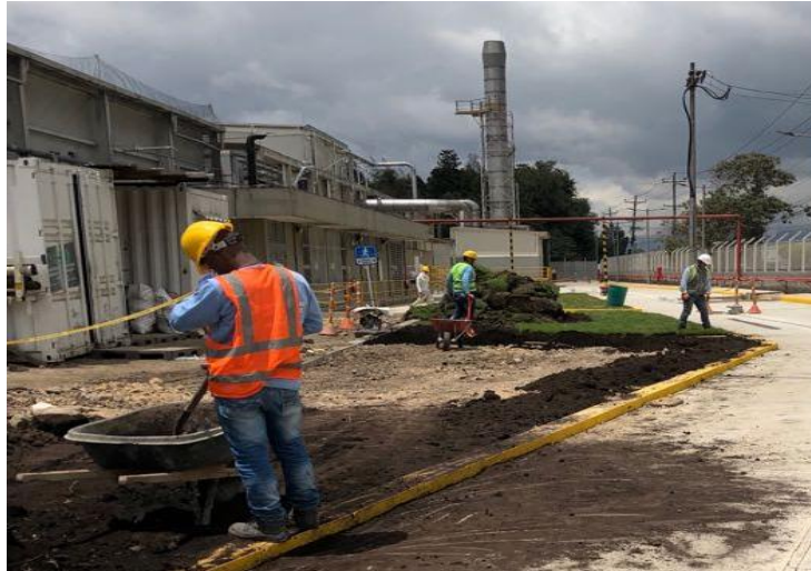
Ilustración 35.Instalación tierra negra y grama.
