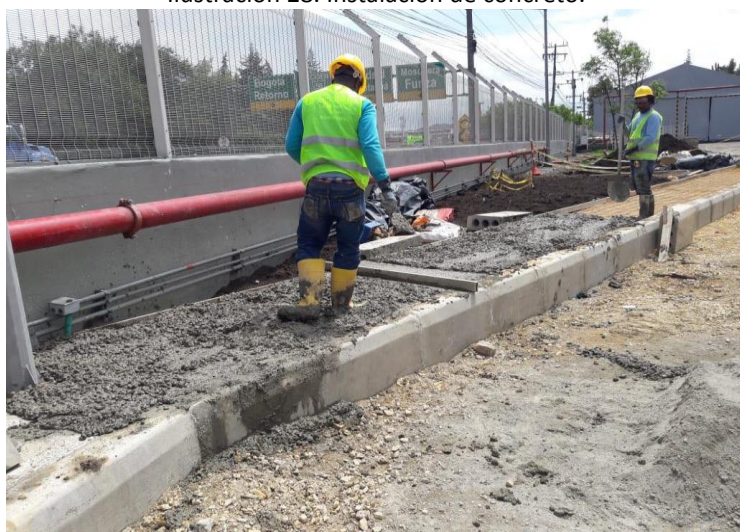
Ilustración 28. Instalación de concreto.
