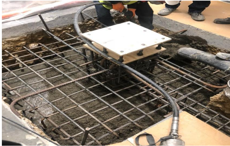
Ilustración 47. Fundida de concreto
