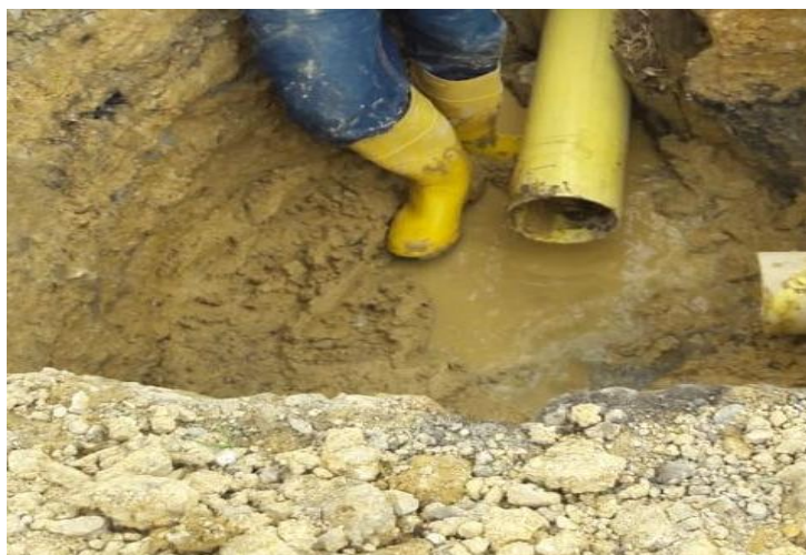
Ilustración 11. Excavación para construcción de caja.
