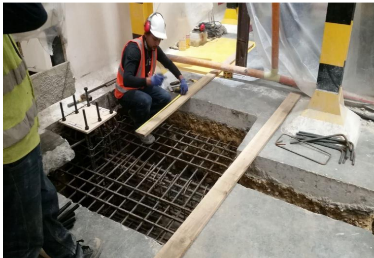
Ilustración 46. Canasta de hierro finalizadas.
