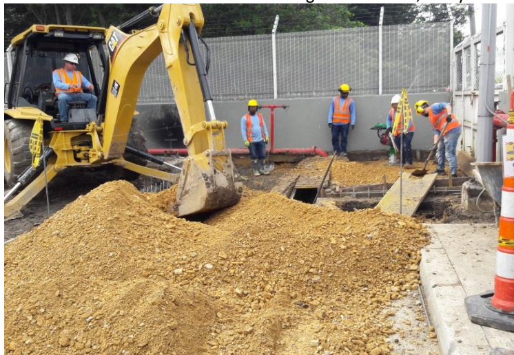
Ilustración 21. Instalación de material granular B-200, 400 y 600.
