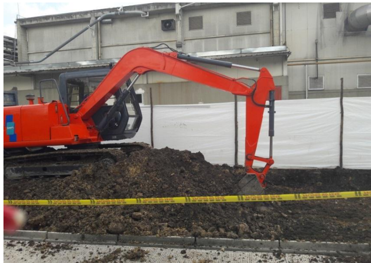
Ilustración 18. Excavación mecánica turba.
