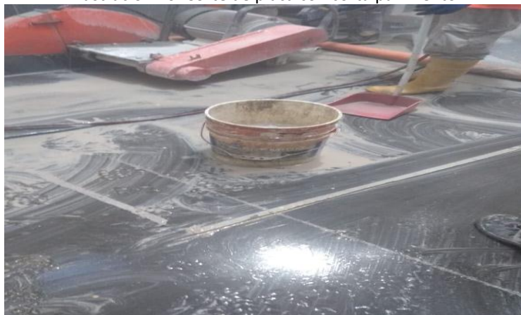
Ilustración 40. Corte de placa con corta pavimento
