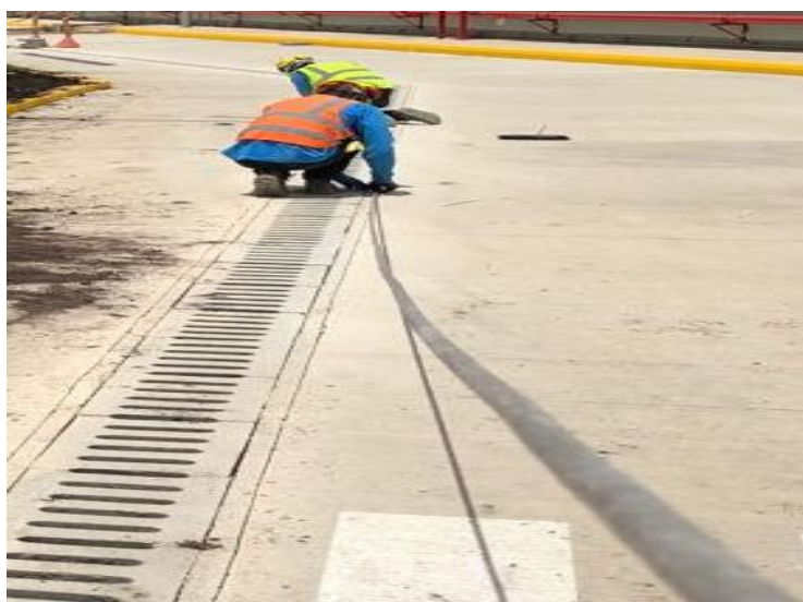
Ilustración 34. Instalación de sika rood y epoxico.
