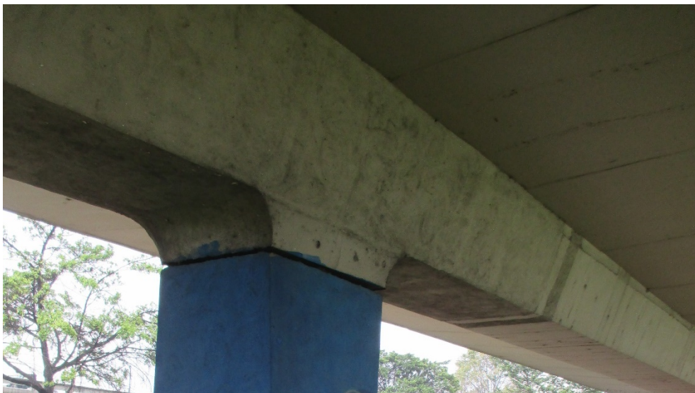
Figura 15 Reforzamiento de la viga principal, en zona de apoyos
