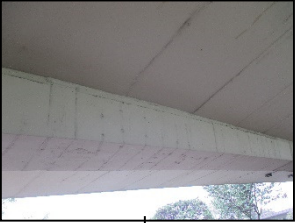
Fisuras inyectadas en vigas y losas
