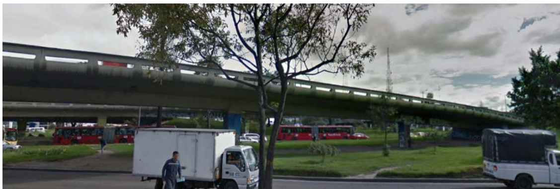
Figura 4 Puente Vehicular Av. de las Américas sobre Av. Batallón Caldas. Acceso occidental
