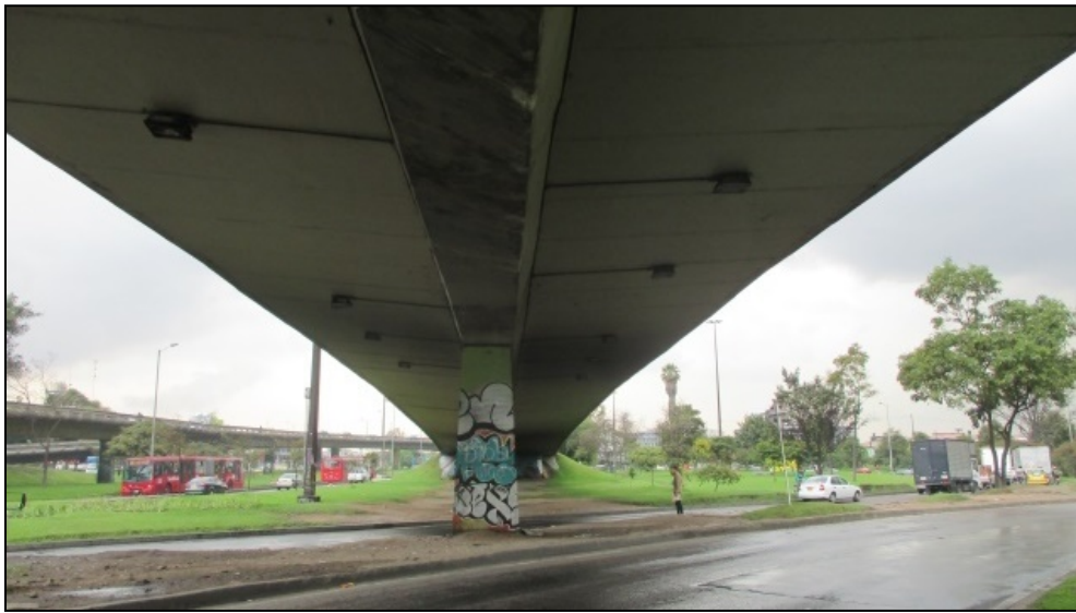
Figura 8 Puente vehicular Av. Américas por Av. Batallón de Caldas Norte – Subestructura
