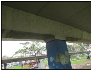
Reforzamiento en columnas y vigas en zona de apoyo
