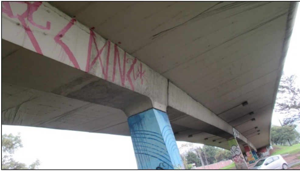
Figura 7 Puente vehicular Av. Américas por Av. Batallón de Caldas Norte – Superestructura
