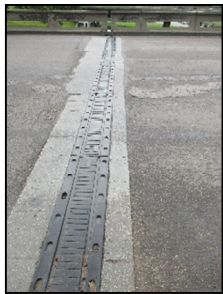
Junta de dilatación en buen estado costado oriental
