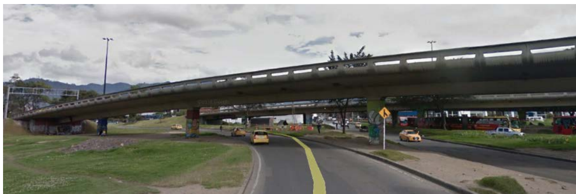
Figura 3 Puente Vehicular Av. de las Américas sobre Av. Batallón Caldas. Acceso oriental
