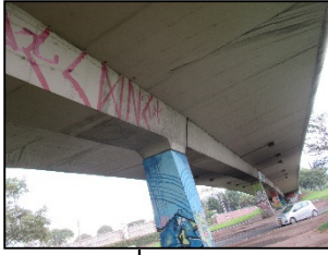
Zona de reforzamiento
