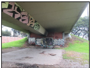
Estribo costado oriental
