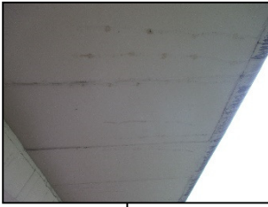
Fisuras inyectadas
