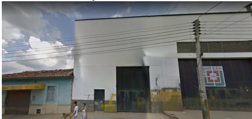
Figura 22. Alturas viviendas Norte del predio
