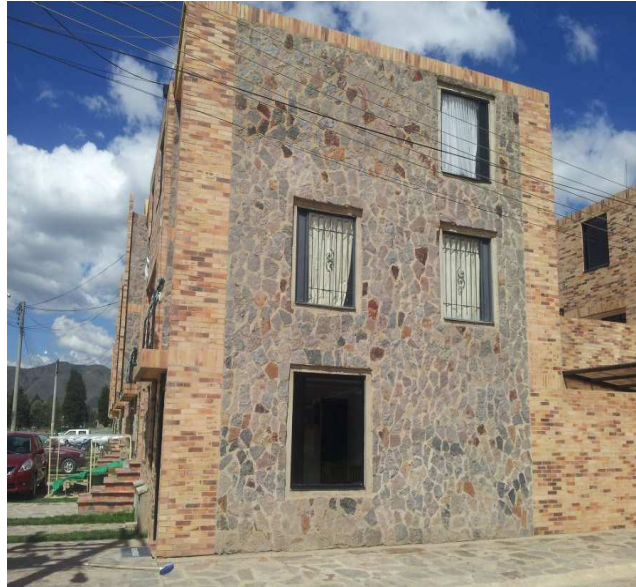
Imagen No. 8: Utilización de lajas rústicas en fachadas de viviendas, Sogamoso – Boyacá.
