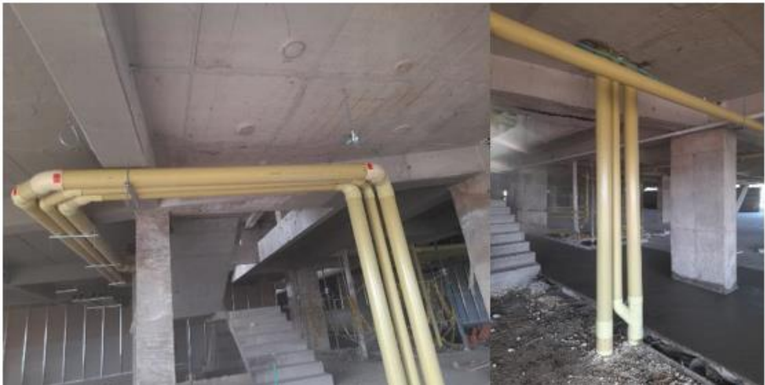
Figura 28. Registro fotográfico para las memorias técnicas – 1
