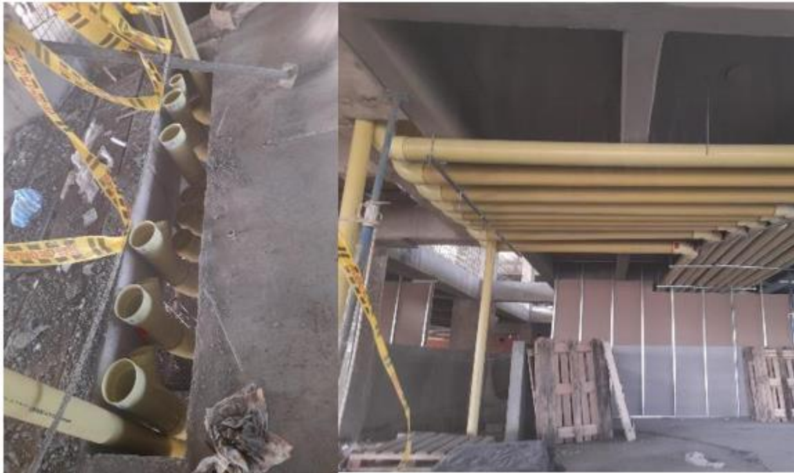
Figura 29. Registro fotográfico para las memorias técnicas – 2
