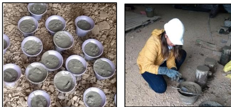
Figura 9. Bloques para asegurar recubrimiento.
