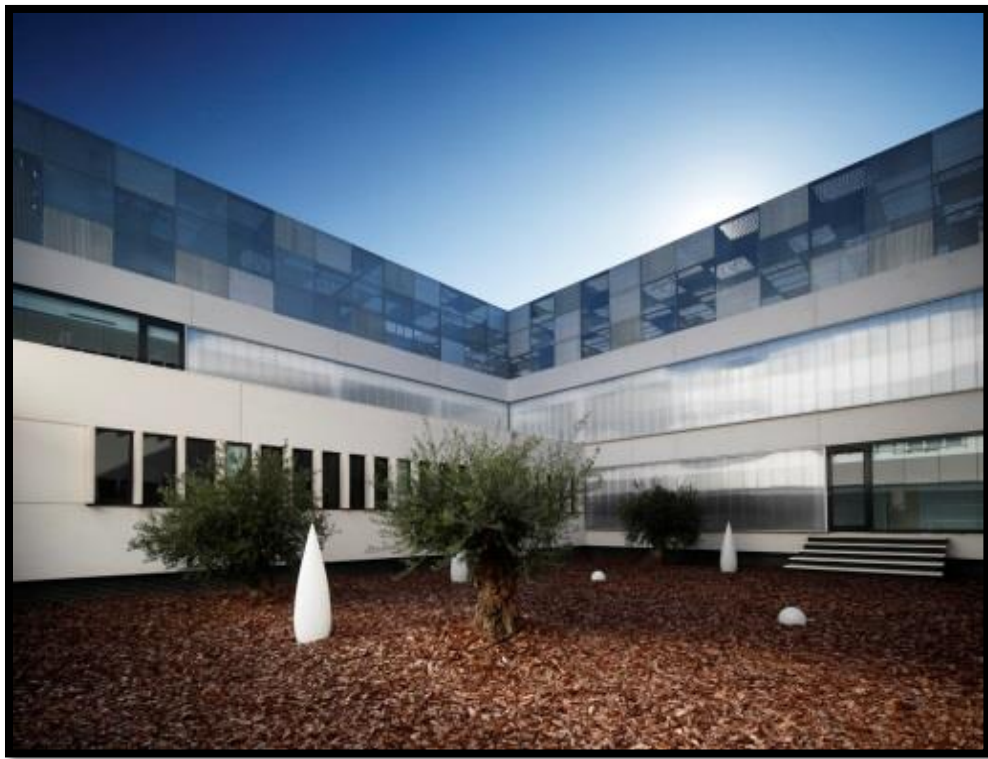
Figura 31. Patio central Centro de salud ciudad real 3
