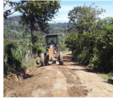
Vereda Maciegall mantenimiento de la vía, limpieza de zanjas y nivelación de la vía. Fuente: Contratista- operador.
