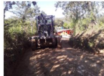
Vereda Maciegall mantenimiento de la vía, limpieza de zanjas y nivelación de la vía; extendida de recebo. Fuente: Contratista- operador.
