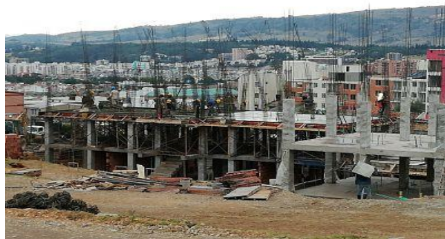
Ilustración 48 Acompañamiento a fundida de losa 3 nivel
