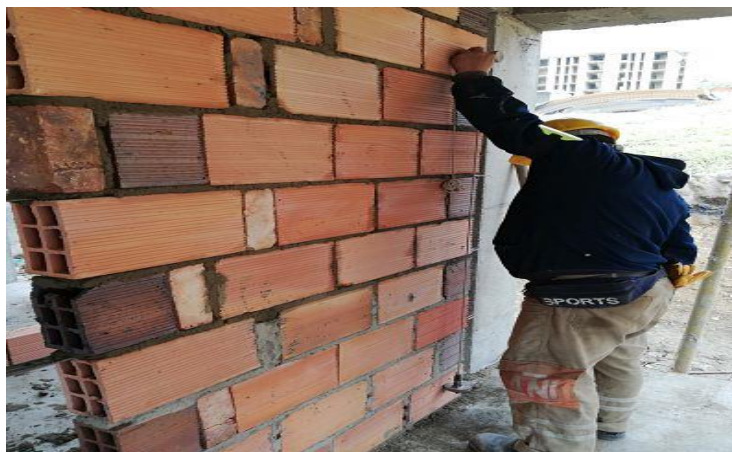
Ilustración 6 Plomada de mampostería de interior B1TA
