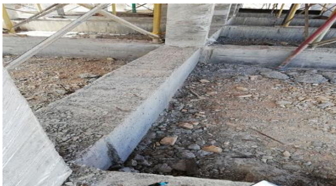
Ilustración 1 Vigas de cimentación B1TB
