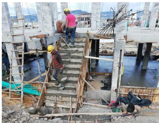
Ilustración 27 Acompañamiento a fundida de escalera B2TB
