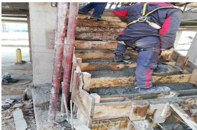
Ilustración 36 Fundida de escalera B4TB nivel 1.
