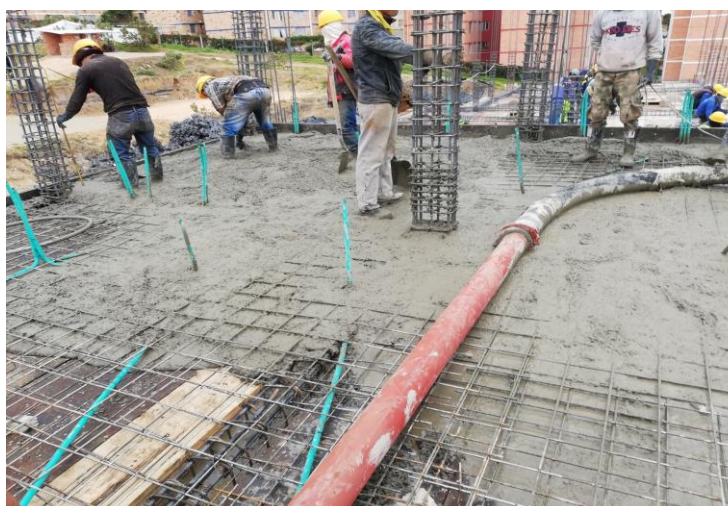
Ilustración 14 Acompañamiento fundida de la losa entrepiso nivel 3 B1TB
