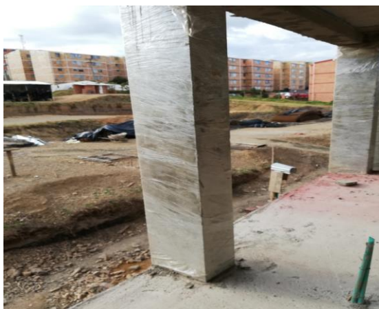
Ilustración 22 Columnas B2TB Nivel 2
