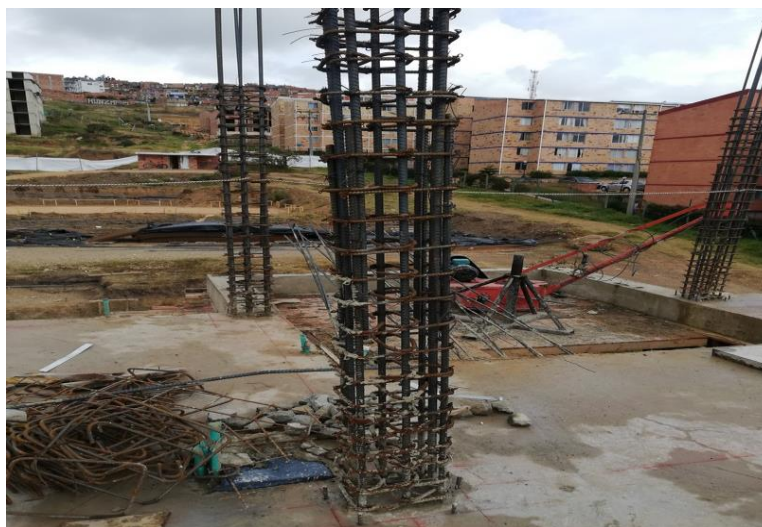
Ilustración 52 Columnas B5TB nivel 4
