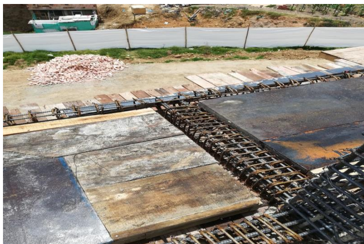
Ilustración 9 Losa de entrepiso nivel 4 B1TA
