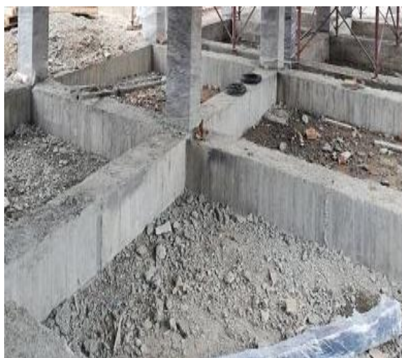
Ilustración 31 Vigas de cimentación B4TB
