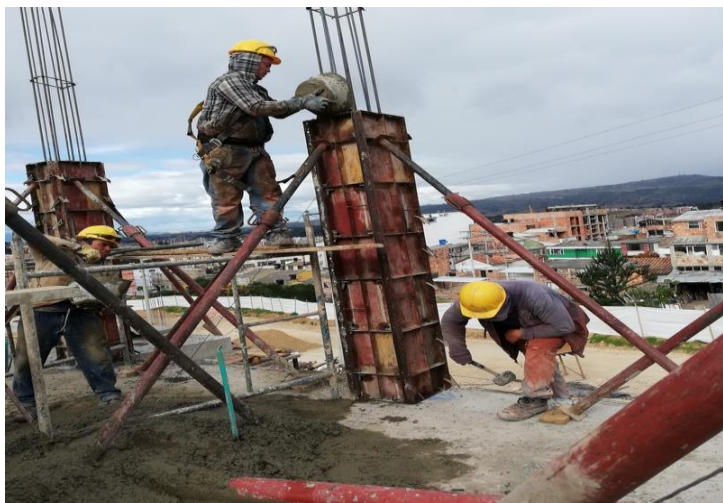
Ilustración 17 Fundida columnas nivel 3 B1TB
