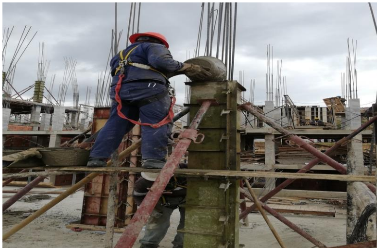
Ilustración 39 Fundida de columnas B4TB nivel 3
