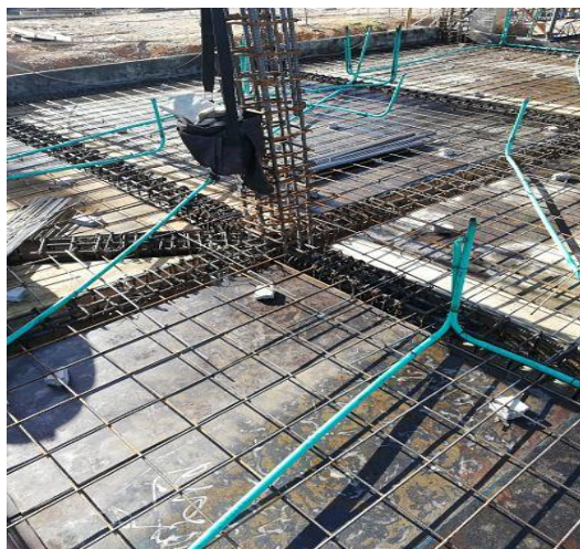
Ilustración 33 Verificación separación flejes losa de entrepiso nivel 2
