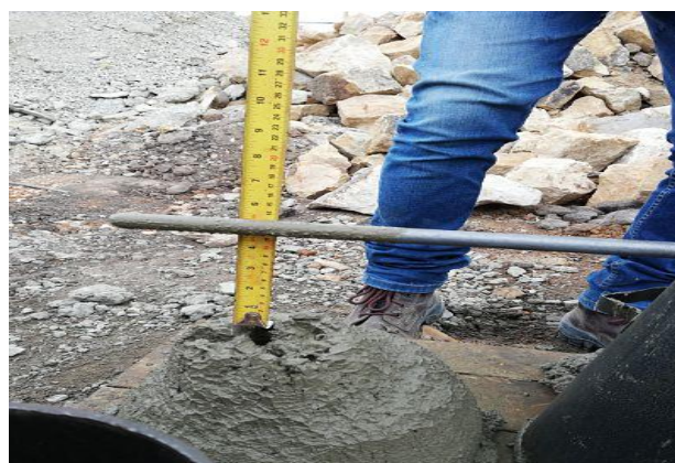
Ilustración 49 Slump Asentamiento de 5.5"
