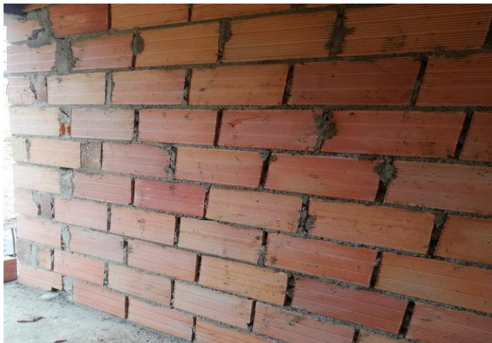
Ilustración 8 Muro de interior B1TA
