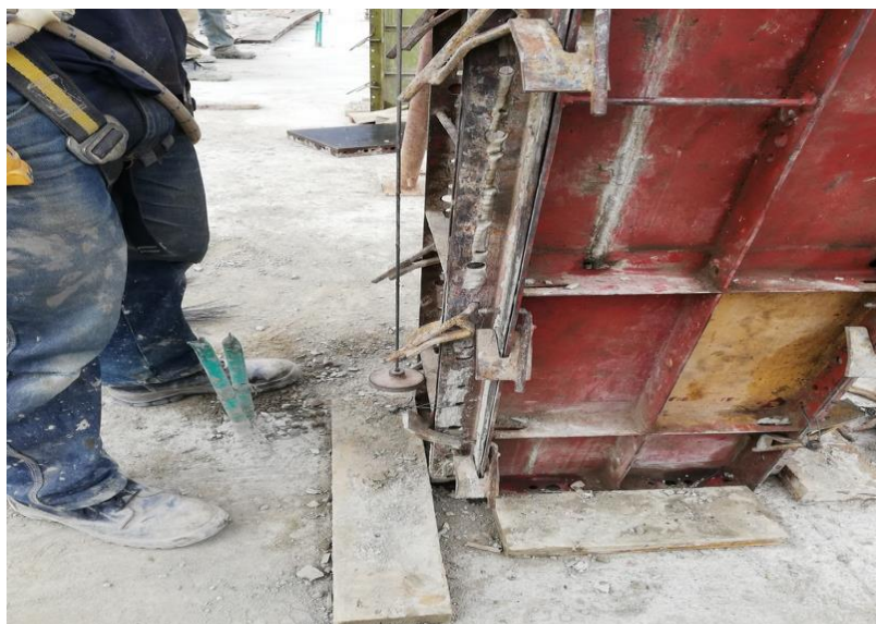
Ilustración 38 Variación de plomada columna B4TB Nivel 4
