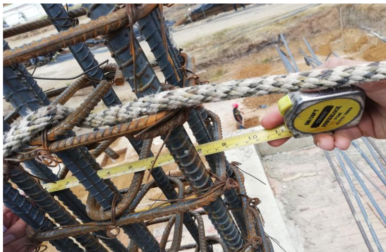
Ilustración 53 Verificación de la dimensión de los estribos B5TB
