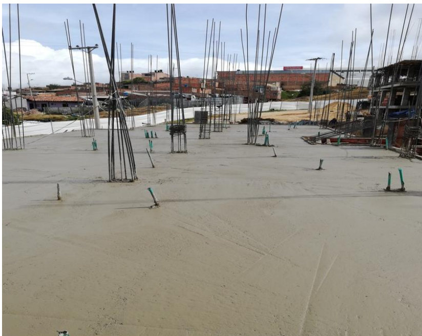
Ilustración 37 Terminación de fundida losa de entrepiso nivel 3 B4TB
