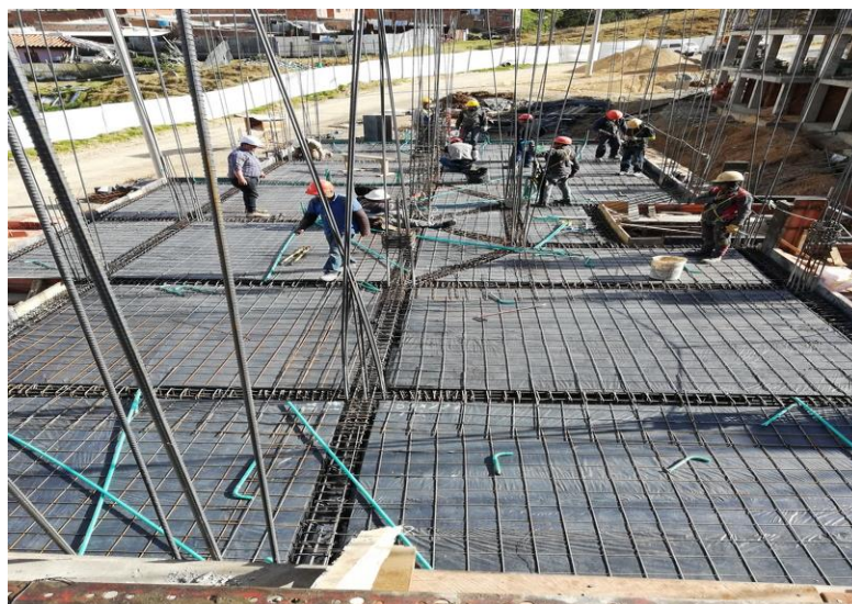
Ilustración 40 Losa de entrepiso nivel 3 B4TB.
