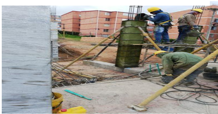
Ilustración 5 Acompañamiento a fundida de las columnas B1TA nivel 2
