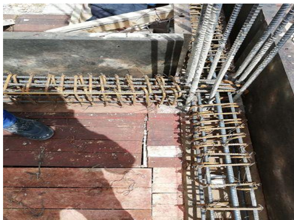
Ilustración 23 Verificación de distanciamiento de flejes losa de entre piso 2 nivel.
