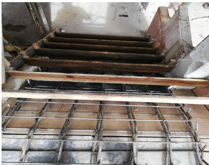
Ilustración 35 Escalera B4TB nivel 1.
