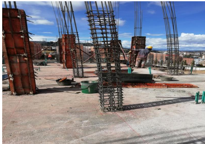
Ilustración 16 Encofrado de las columnas B1TB Nivel 3
