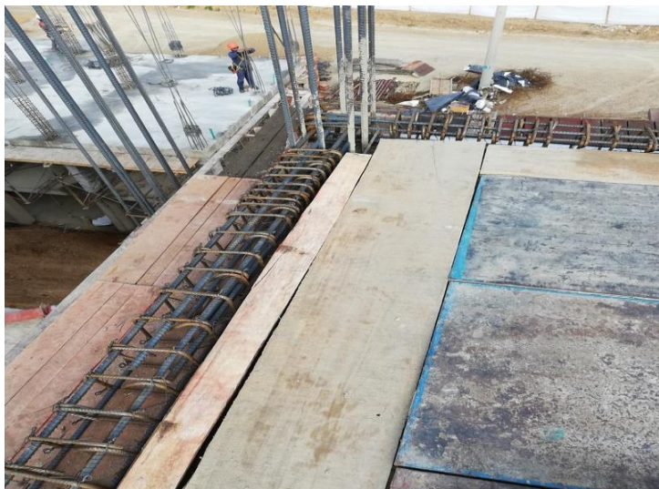
Ilustración 13 Losa de entrepiso nivel 4 B1TA.
