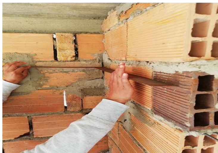
Ilustración 7 Escuadra en esquina del muro de interior B1TA
