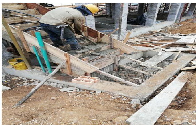
Ilustración 46 Acompañamiento de fundida de la escalera B5TB
