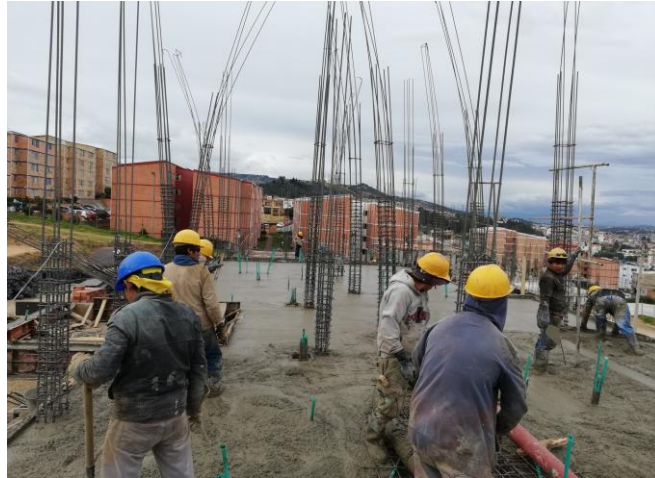
Ilustración 15 Losa de entrepiso nivel 3 B1TB
