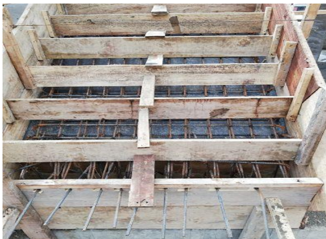
Ilustración 45 Aceros de la escalera B5TB
