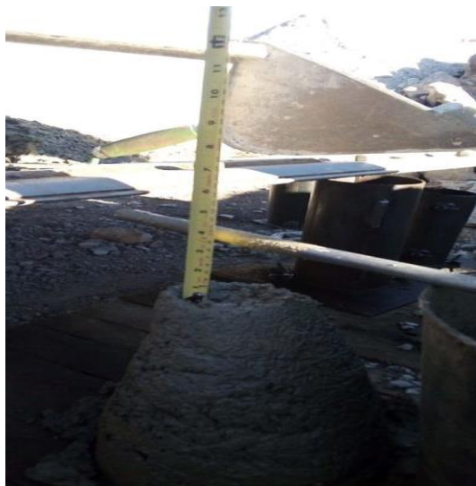
Ilustración 26 Slump concreto aplicado en la losa B2TA nivel 2
