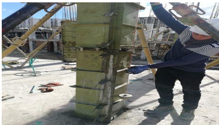
Ilustración 3 Encofrado de columnas B1TA 2 nivel
