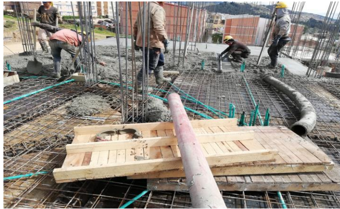
Ilustración 19 Fundida losa de entrepiso nivel 4 B1TB
