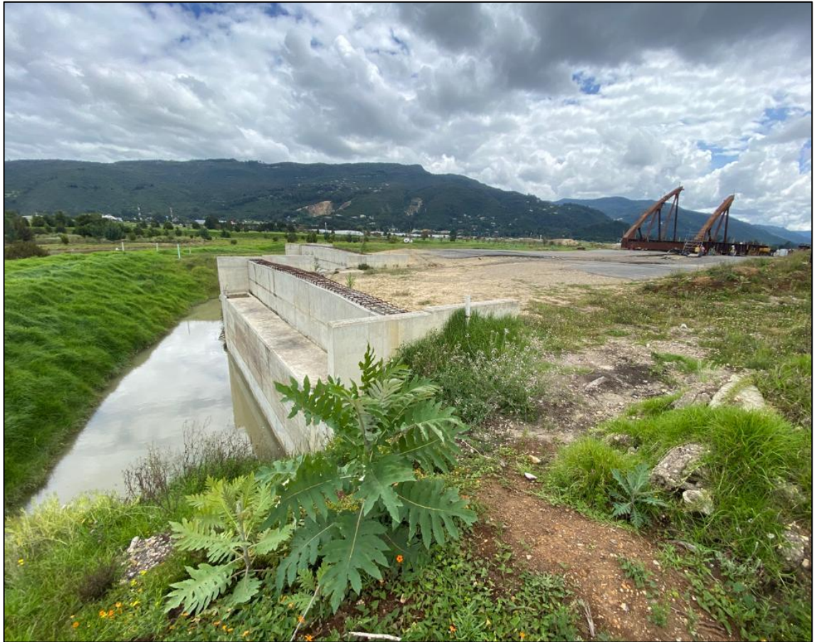
Imagen. 4. Fin del tramo en doble calzada ya construida en la unidad funcional 3 “Carretera de los Andes”. Fuente: Captura propia.
