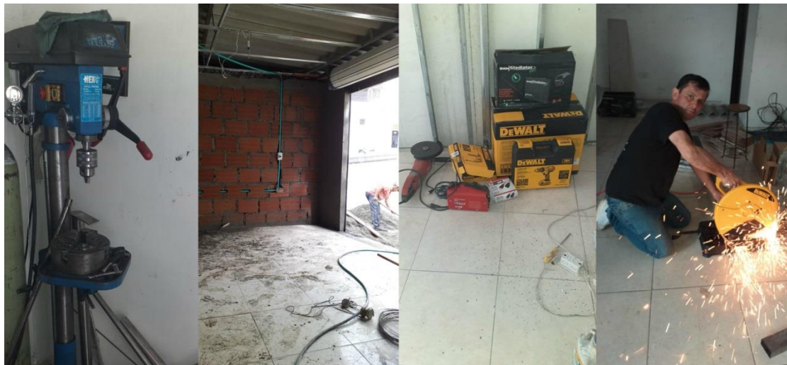
Ilustración 24. Puesta en marcha de Metálica Morales.
