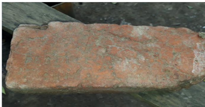
Ilustración 2. Ladrillo recopilado de la fábrica de Teófilo López, registro fotográfico propio 2020
