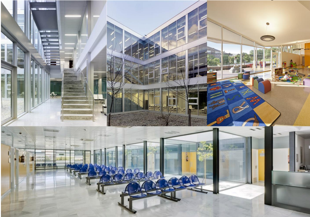
Figura 76. Fachadas de los Centros de Salud Mediterráneo Norte, A Parda y Adamsville.
