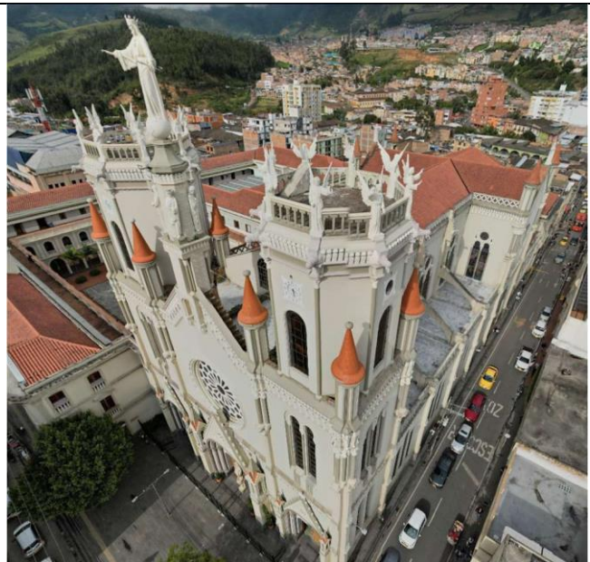
Arbotantes, gárgolas, pináculo y contrafuerte Fuente: Los Autores
