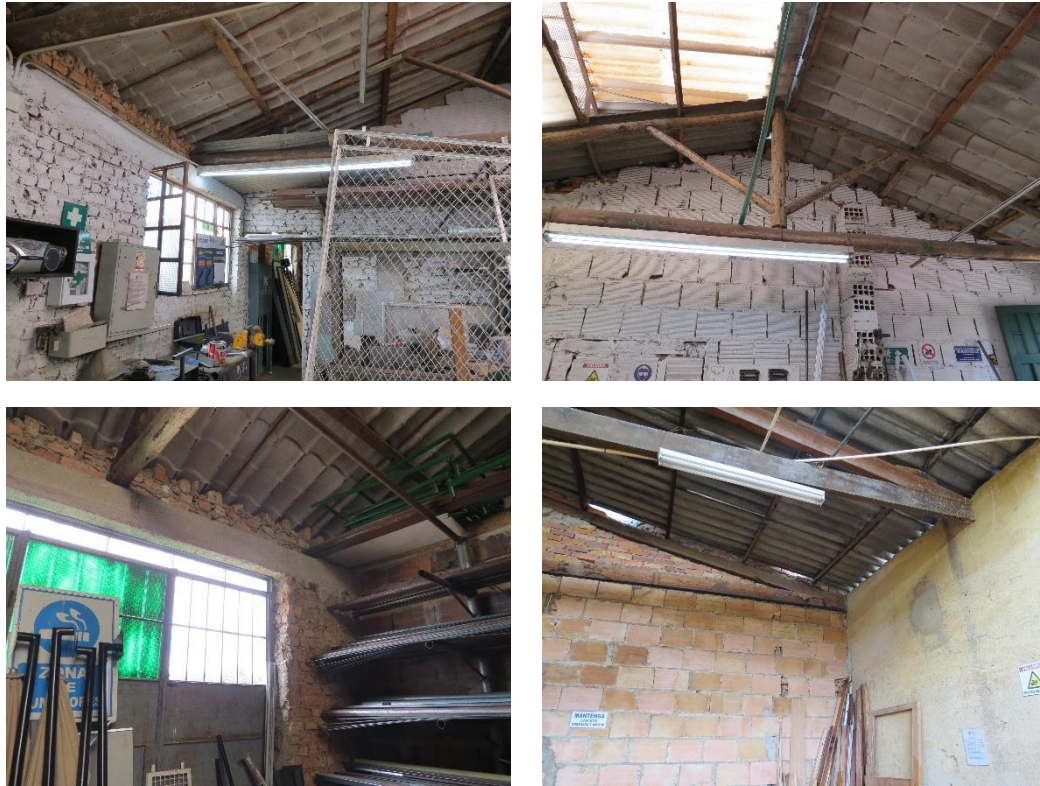
Imagen 38: Sistema de muros de carga
