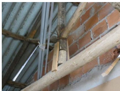
Imagen 64 Reparación inadecuada de nudo
