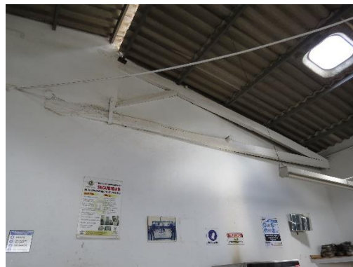
Imagen 57 Cercha confinada con muro costado laboratorio
