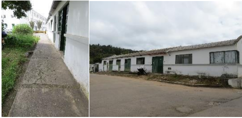
Imagen 68 Canal de piso actual
