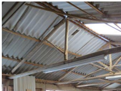
Imagen 62 Estructura de cubierta
