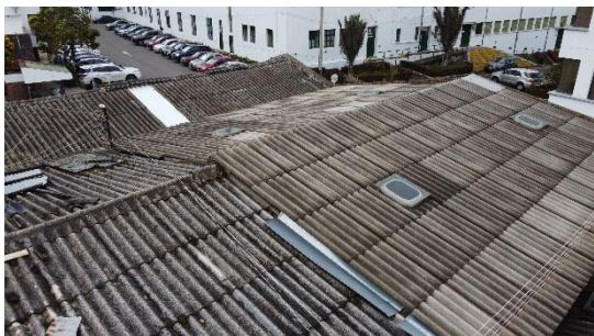
Imagen 54 Cubierta estado actual
