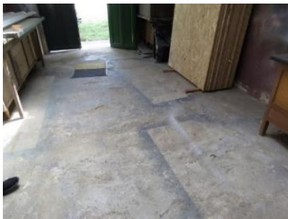
Imagen 72 Placa de contrapiso actual
