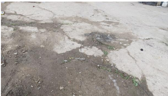
Imagen 70 Placa de contrapiso actual
