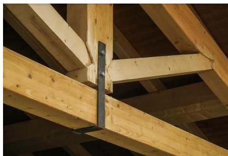
Imagen 65 Ejemplo reparación nudo
