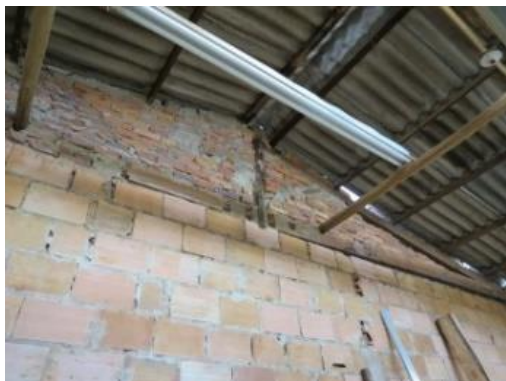
Imagen 56 Cercha confinada con muro costado carpintería
