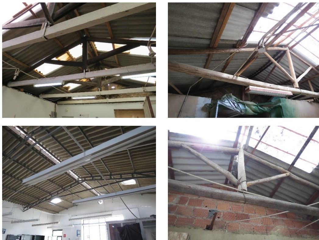
Imagen 39 Cubierta cerchas en madera y metal
