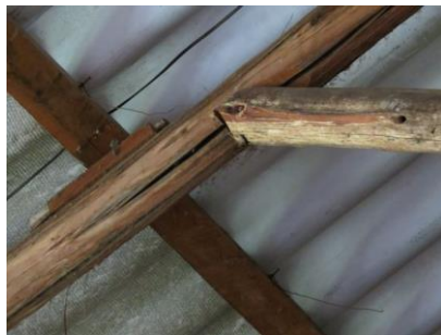
Imagen 60 Estructura de cubierta
