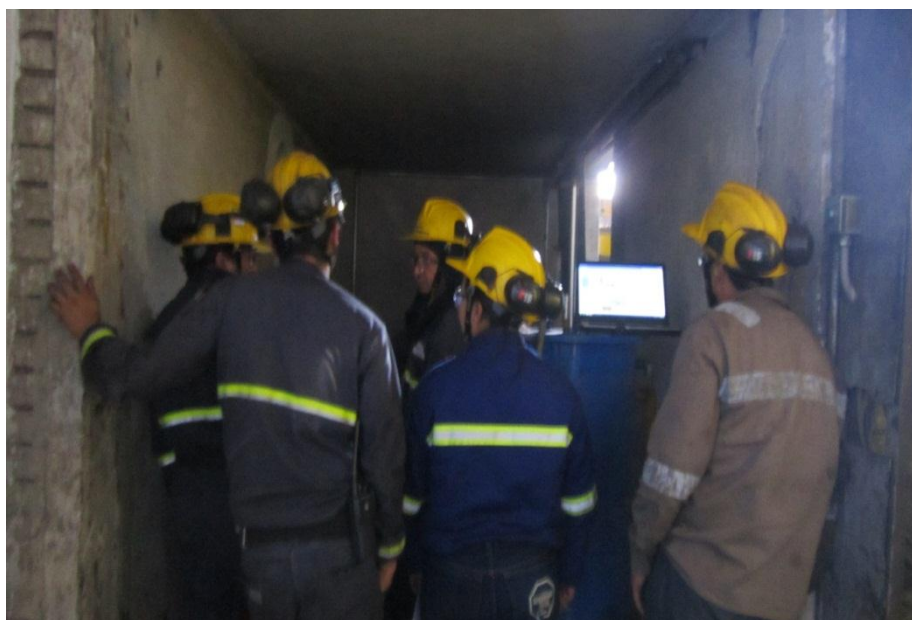
Imagen 499. Pruebas de alarmas del sistema.
