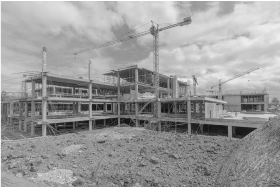
Figura 8. Ejemplo de sistema tipo pórtico en construcción
