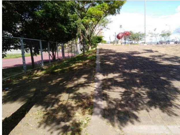
Figura 8. Malas prácticas en la accesibilidad de la plazoleta pública.
