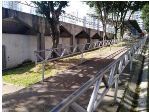
Figura 2. Desnivel de rampas inadecuado.
