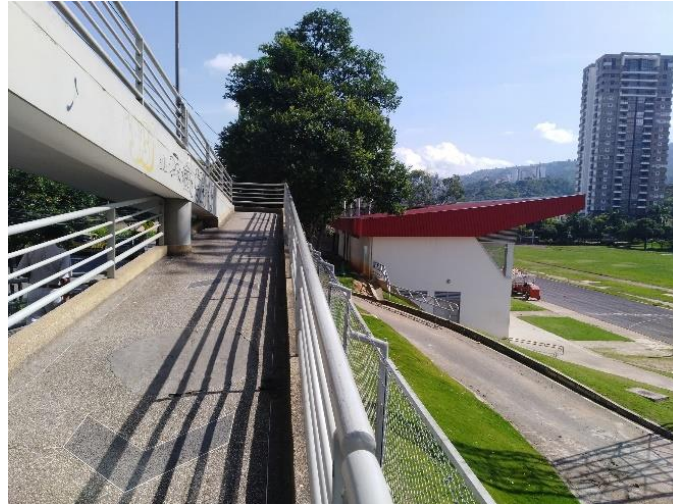
Figura 30. Puente peatonal junto al estadio de atletismo.
