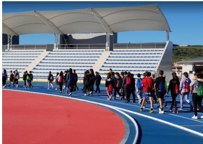
Figura 69. Membrana y estructura metálica.
