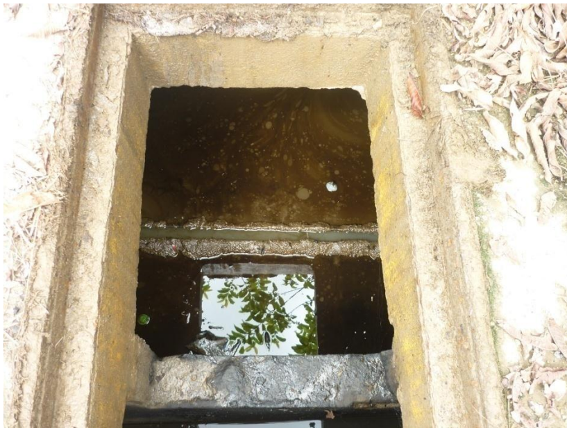
Trampas de grasa en Estación de Servicio, llena de residuos de hidrocarburos.
