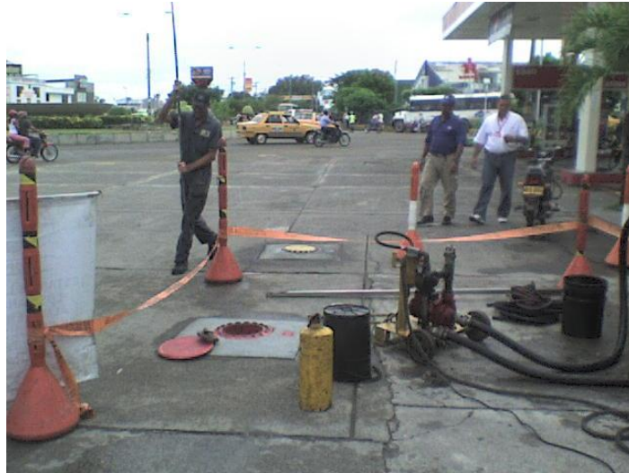
Figura 6. Actividad de limpieza de tanques de combustible.
