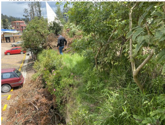
Ilustración 22.Vista estado actual del cerramiento
