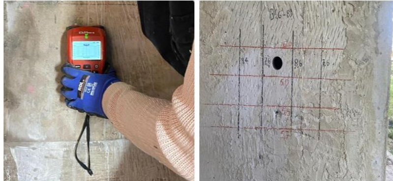
Ilustración 17 Toma de datos ensayo detección de refuerzo
