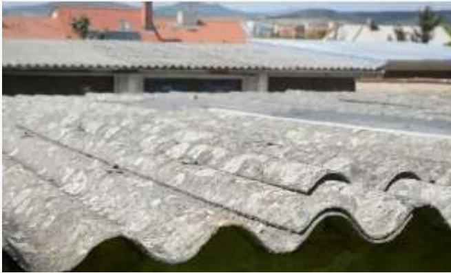
Placas onduladas de fibrocemento, cubiertas, paredes
