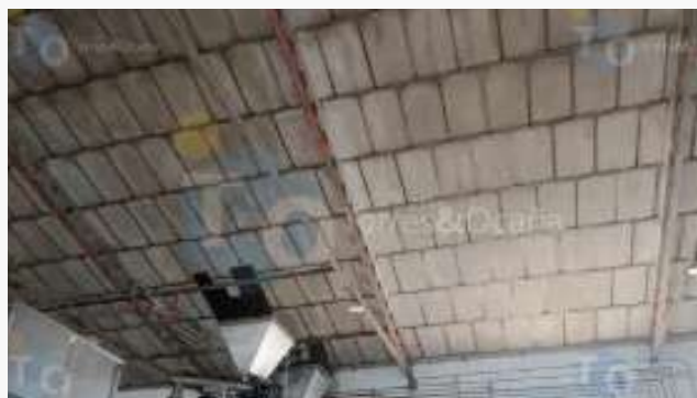
Falsos techos de fibrocemento
