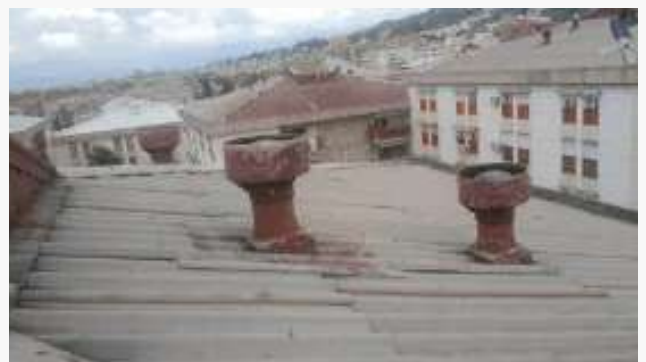
Chimeneas de fibrocemento
