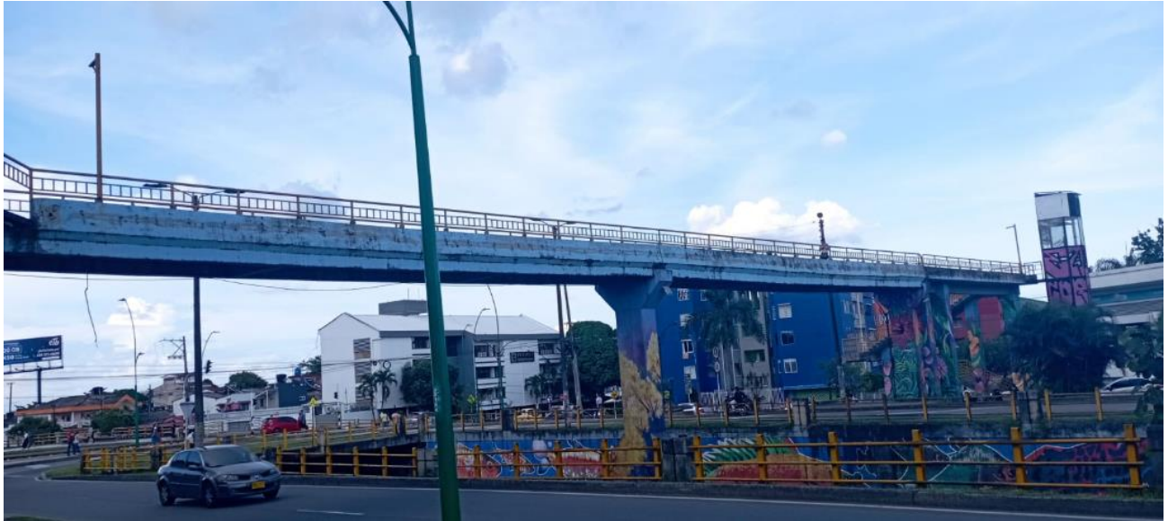
Figura 1. fotografía del puente
