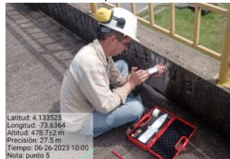
Figura 19. Bordinillo con refuerzo expuesto, Bordinillo 3
