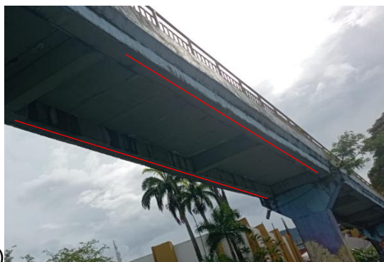
Figura 20 y 21. A) sistema transversal con dos vigas entre el eje E y G, B) sistema transversal con una viga central entre el eje E y B.
