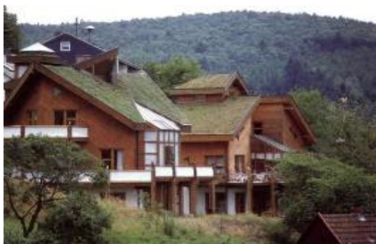
Figura 18. Techos de césped con 45° de inclinación, Siegen-Oberscheiden (Alemania).
