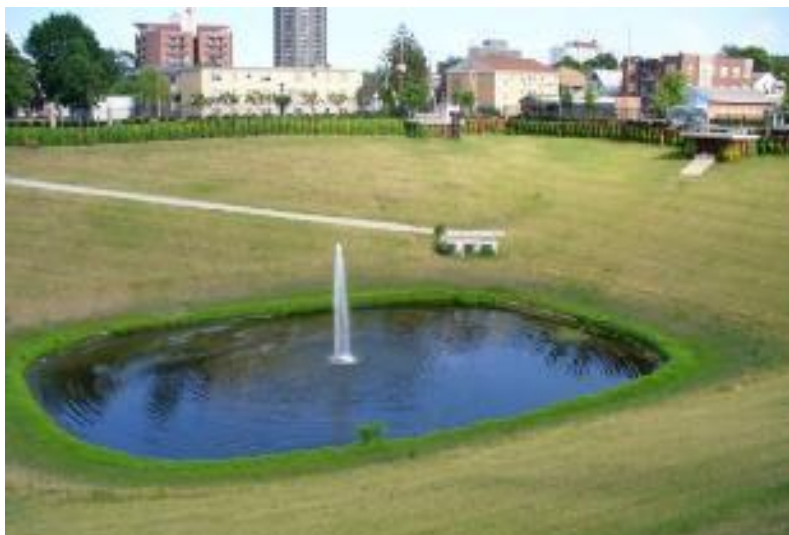
Figura 23. Depósito superficial de detención.
