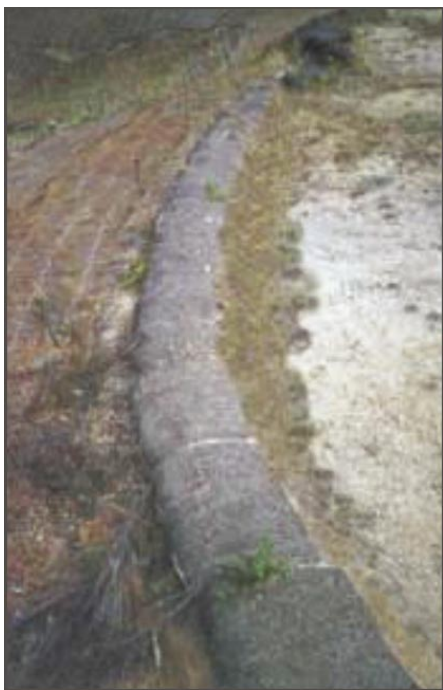
Foto No. 10. Cubrimiento de taludes con sacos rellenos de tierra.
