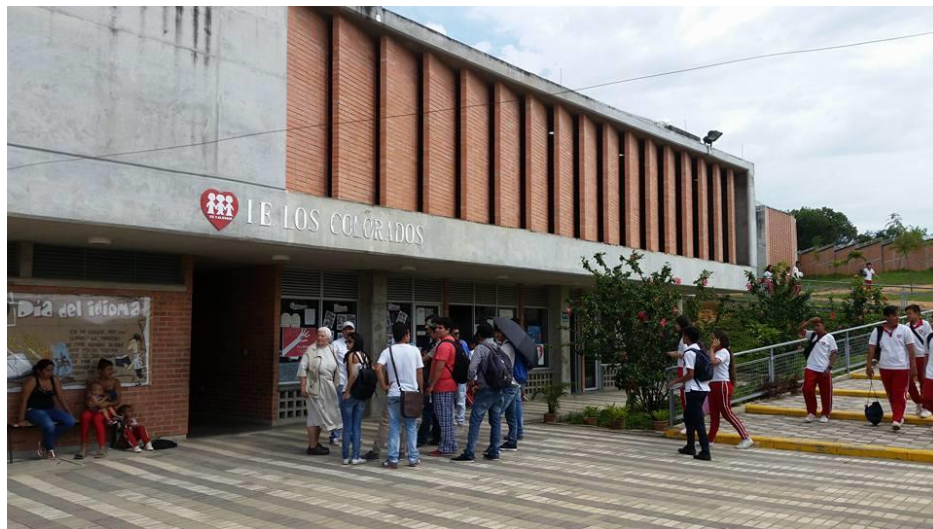
Figura 22. Fachada biblioteca institución educativa Los Colorados.
