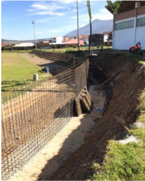
Figura 30. Vaciado del concreto en la base del muro.
