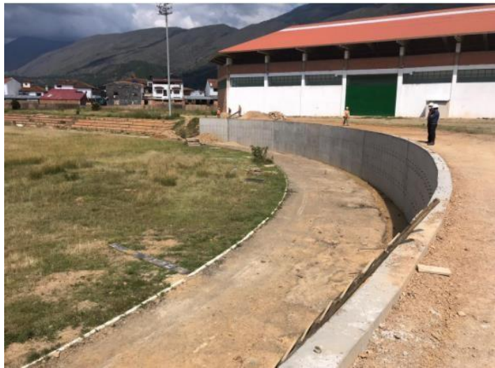
Figura 33. Muro de contención finalizado.
