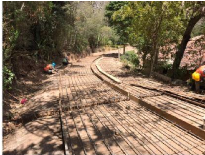
Figura 38. Instalación de mallas de refuerzo de la placa huella.
