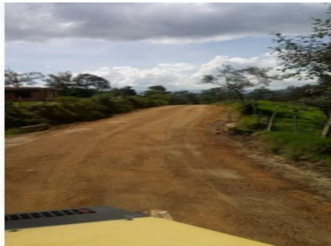
Figura 44. Vía después de la compactación del material recebo.
