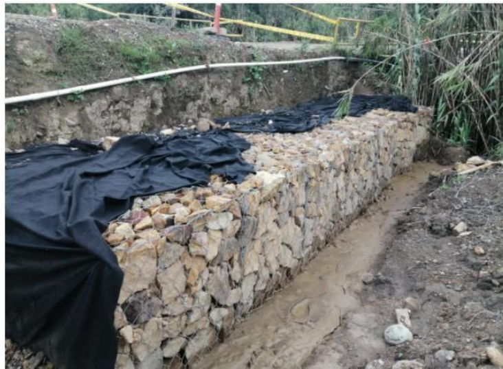
Figura 25. Gaviones como obra de estabilización de la vía
