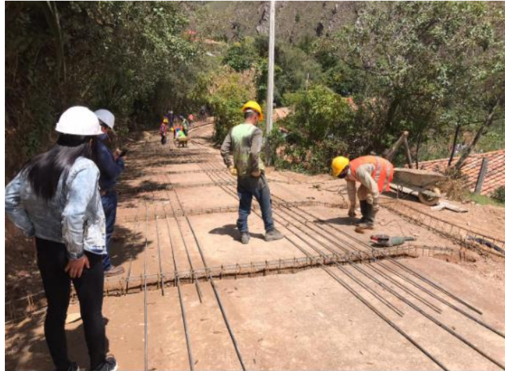
Figura 37. Instalación de la formaleta de la placa huella.
