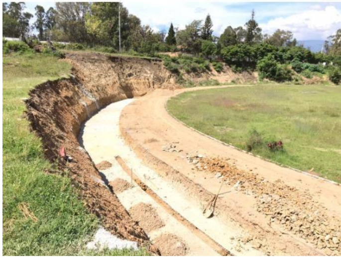
Figura 28. Excavación de la zona trazada.
