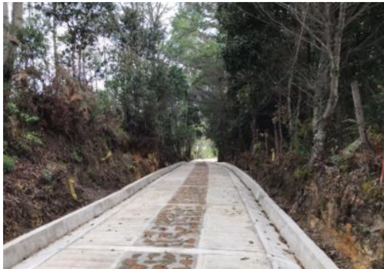
Figura 56. Impacto, placa huella Vereda capilla.
