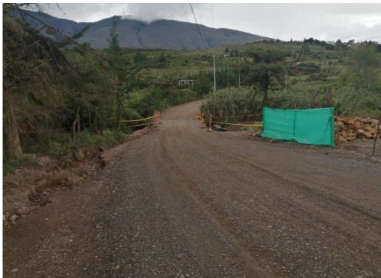
Figura 26. Tramo de la vía con base lista para la carpeta asfáltica.
