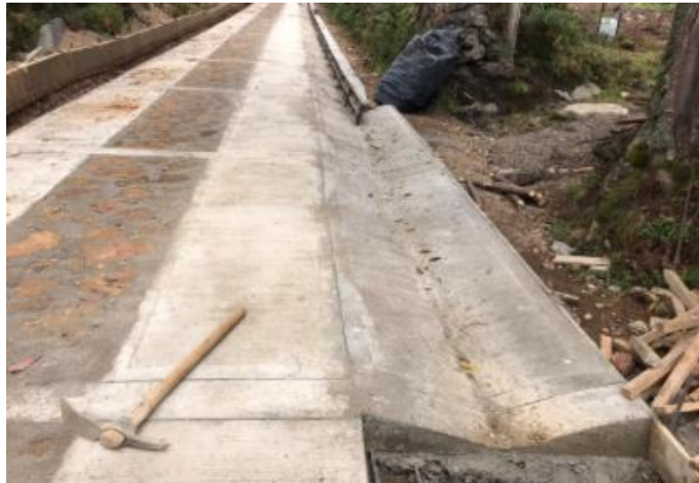
Figura 41. Colocación del concreto en las cunetas.
