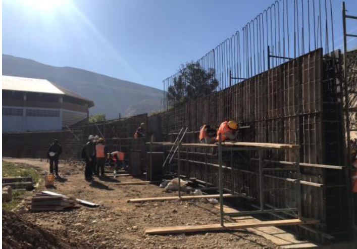
Figura 31. Encofrado del muro de contención.
