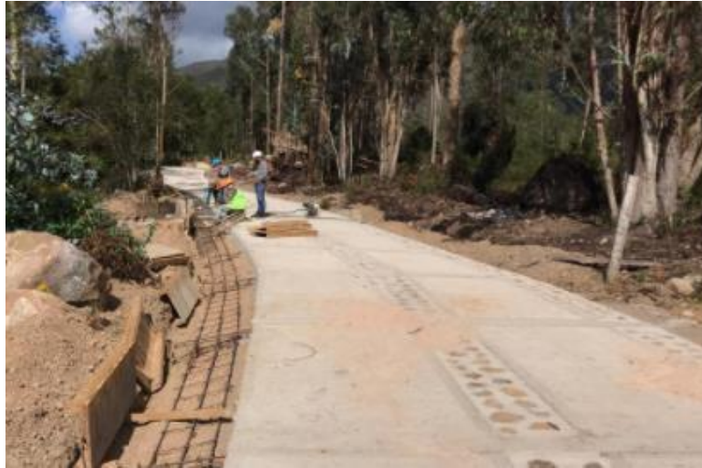
Figura 40. Instalación formaleta de las cunetas.
