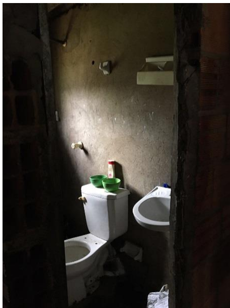
Ilustración 9. Baño de la vivienda.
