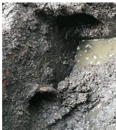
Figura 13: Estado de la cámara de recolección 1. Fuente: autores.
