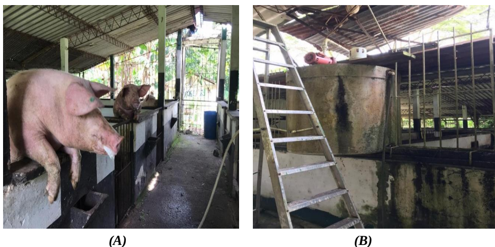
Figura 3: Porqueriza de la I.E. A. de Guacavía, (A): interior de la porqueriza; (B): tanque de abastecimiento de agua. Fuente: autores
