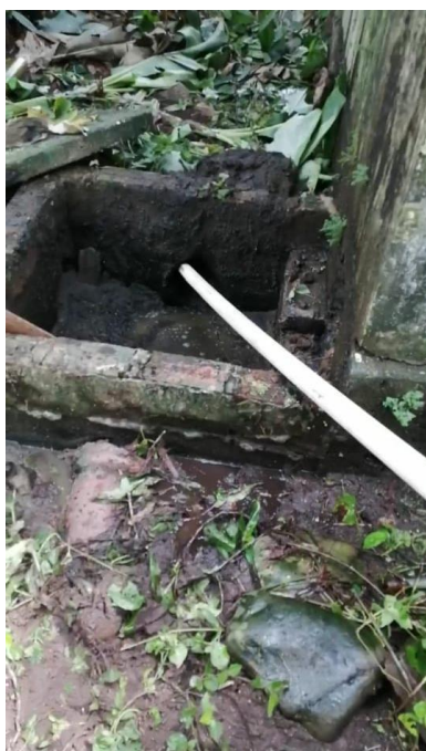
Anexo 4: Destaponamiento de las tuberías de la cámara de recolección 1 al tanque de almacenamiento 1 con agua y un tubo. Fuente: autores.
