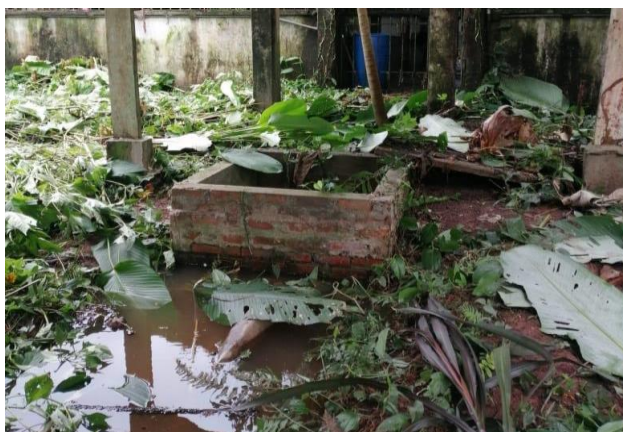
Figura 7: Estado actual del tanque de almacenamiento 1. Fuente: autores.
