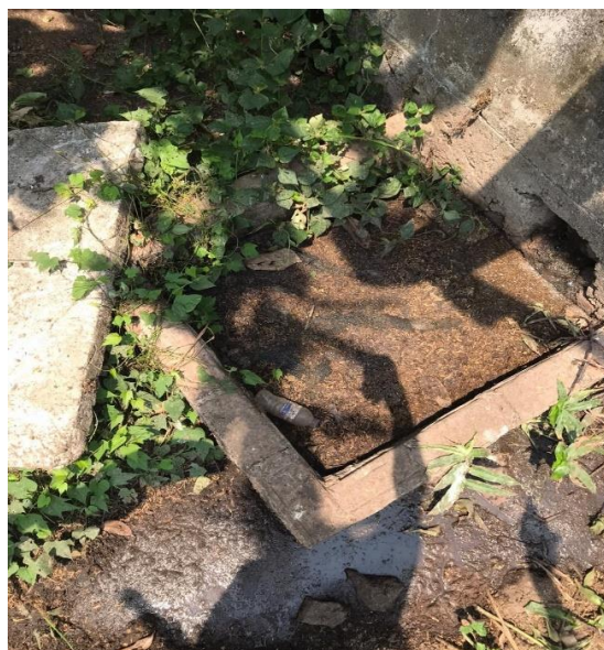
Figura 6: Estado de la cámara de recolección 2, fuente: autores.
