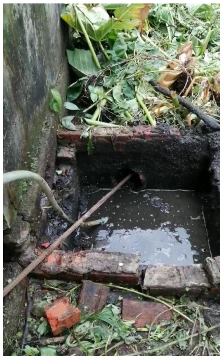
Anexo 5: Destaponamiento de la tubería de la cámara de recolección 2 hacia el tanque de recolección 1. Fuente: autores
