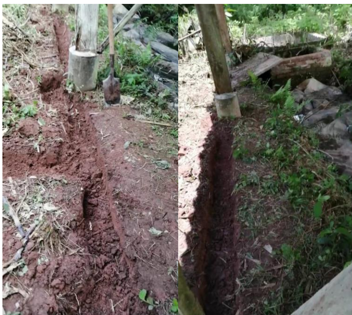
Figura 9: Elaboración del desagüe alrededor de la fosa del biodigestor, fuente: autores.
