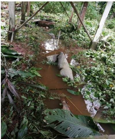
Figura 8: Estado de la fosa del biodigestor. Fuente: autores.
