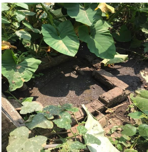
Figura 5: Estado de la cámara de recolección 1, fuente: autores.
