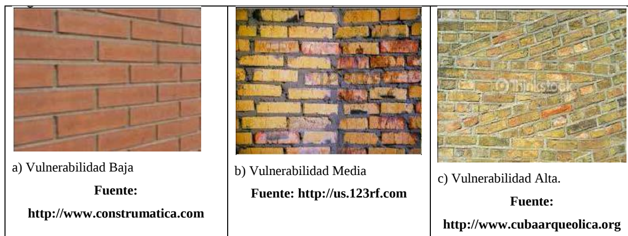
Figura 27. Estimación de vulnerabilidad a partir de la distribución de los ladrillos.
