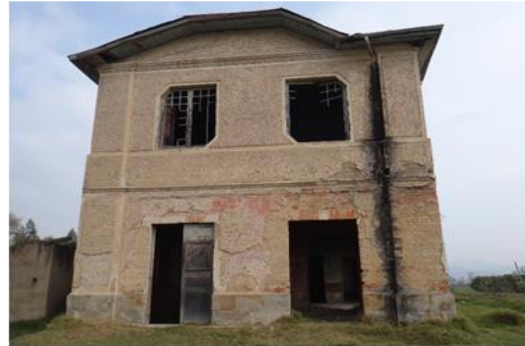
Fachada Lateral Norte
