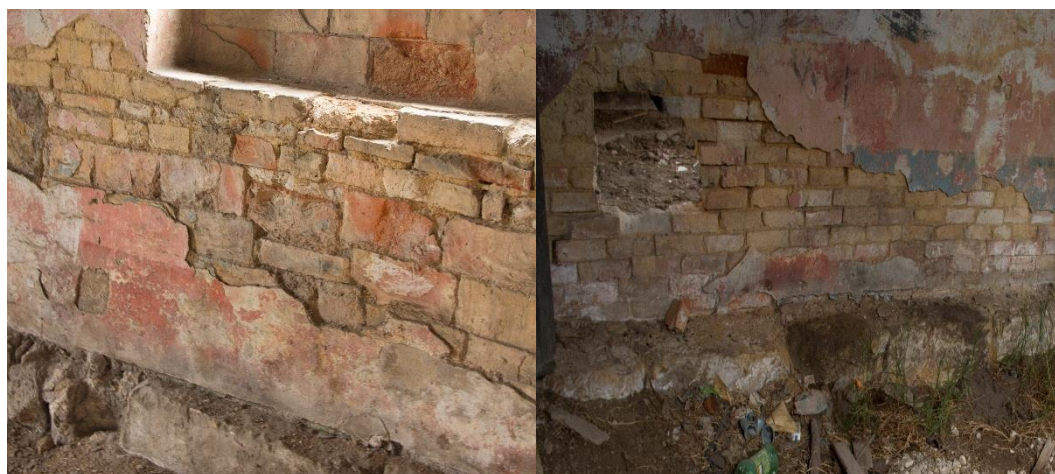
Figura 26. Distribución de Ladrillos Fuente: Elaboración Propia
