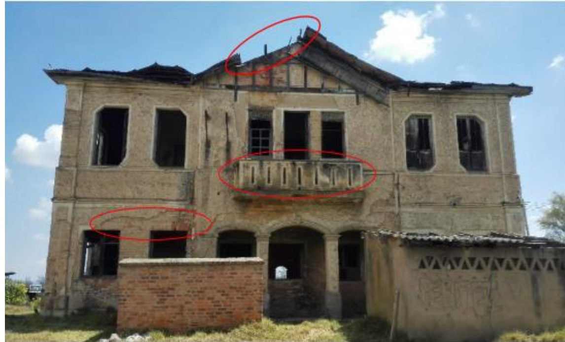
Figura 14. Fachada Principal Fuente: Elaboración Propia
