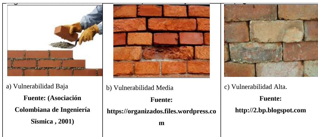
Figura 25. Detalle de las Juntas de Pega Fuente: Elaboración Propia
