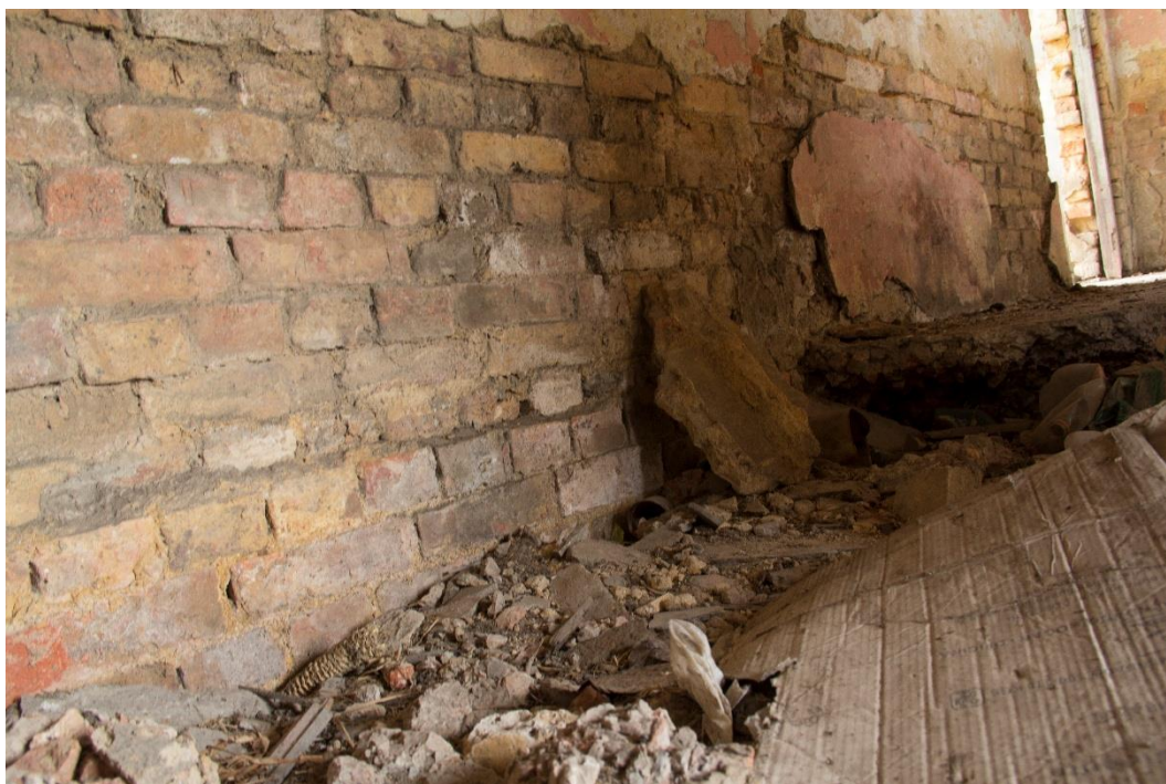
Figura 24. Detalle de las Juntas de Pega
