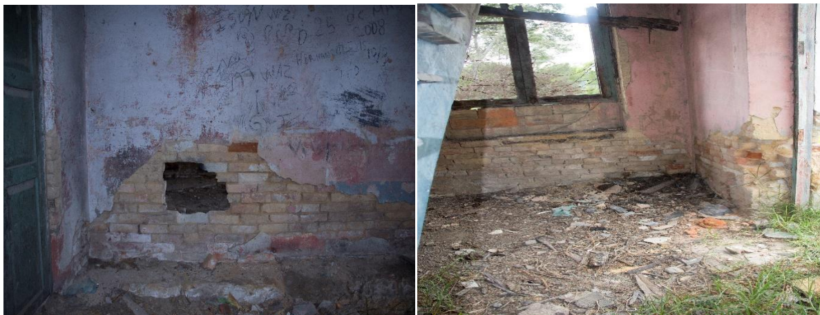
Figura 55. Roturas de las Bases
