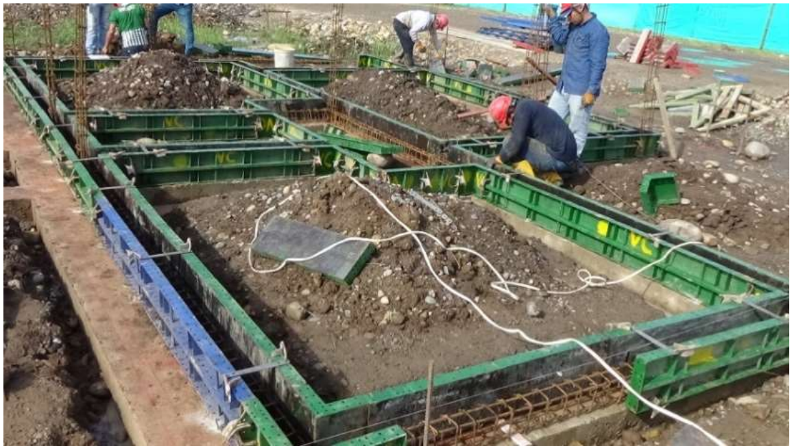
Fotografía 17. Encofrado en formaleta metálica de viga de cimentación - Villa David etapa III
