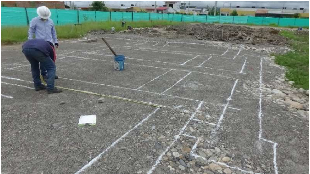
Fotografía 6. Replanteo de ciclópeos - Villa David etapa III
