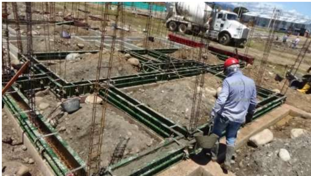
Fotografía 18. Fundición de viga de cimentación - Villa David etapa III
