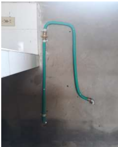
Fotografía 3. Instalación interna de red de gas domiciliaria - Villa David etapa III
