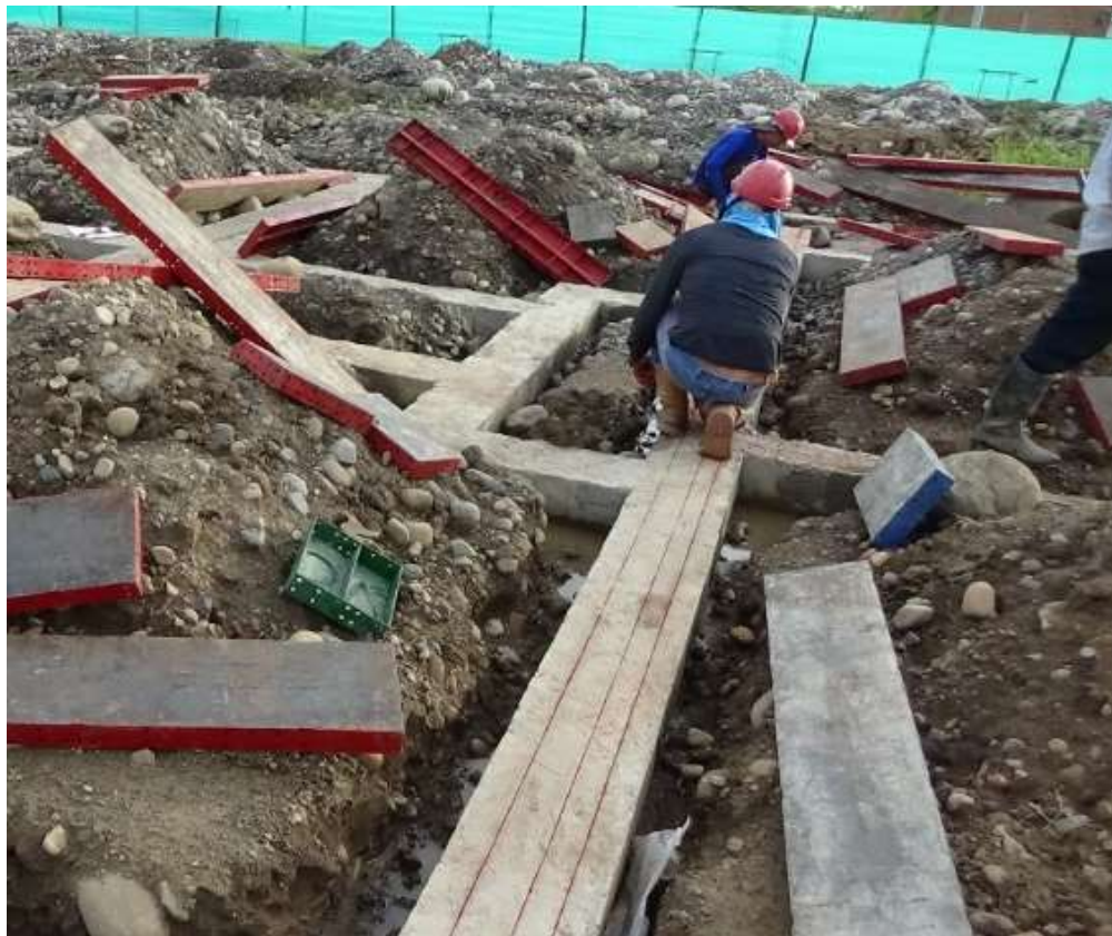
Fotografía 15. Replanteo viga de cimentación - Villa David etapa III
