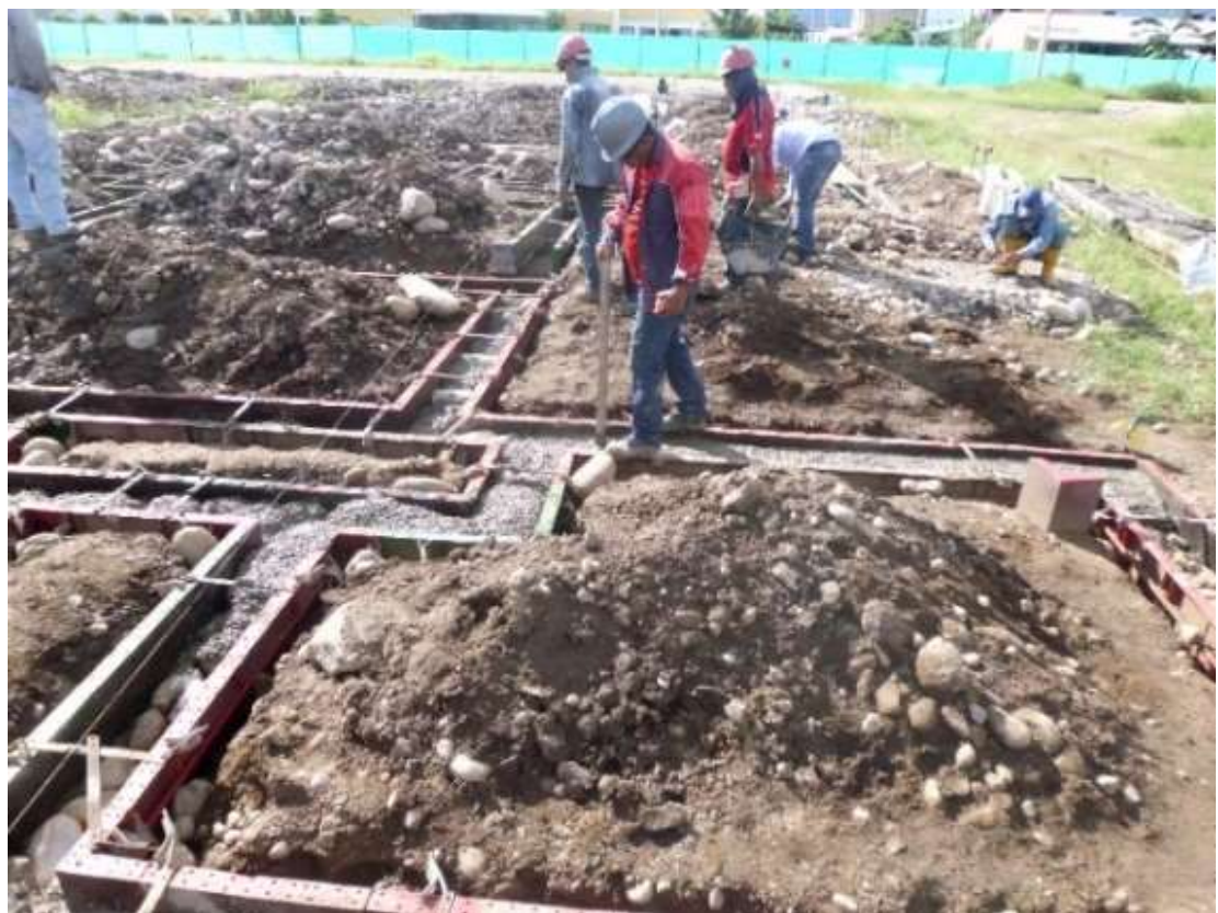
Fotografía 14. Fundición de ciclópeos - Villa David etapa III
