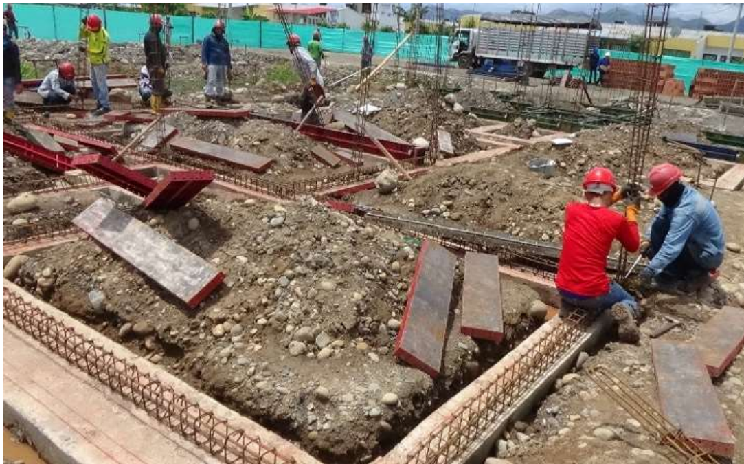
Fotografía 16. Instalación de acero de refuerzo - Villa David etapa III
