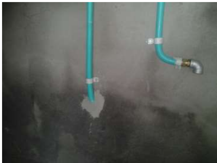
Fotografía 4. Resane de muro de cocina de la unidad de vivienda -Villa David etapa III.
