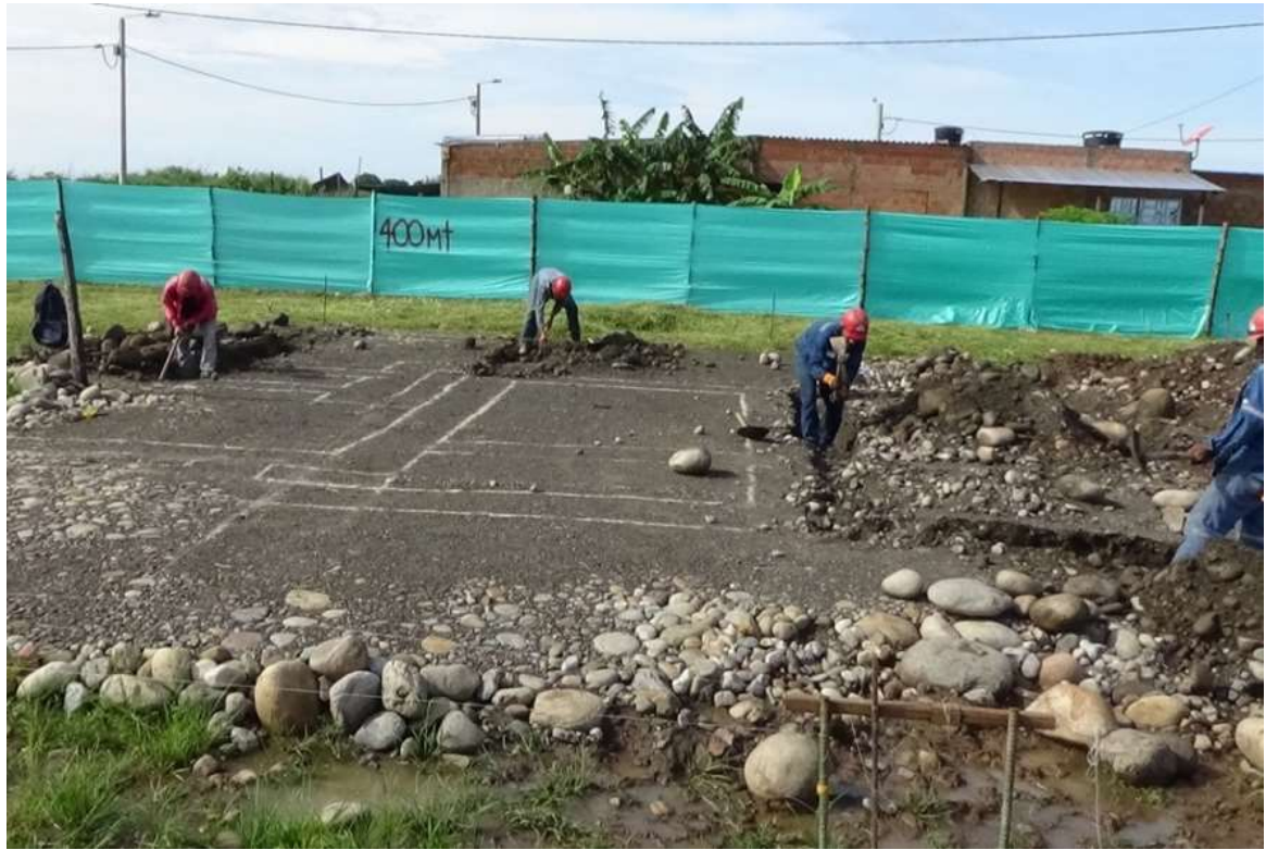
Fotografía 7. Excavación manual de ciclópeos - Villa David etapa III
