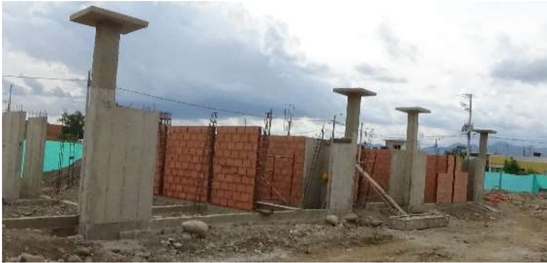
Fotografía 21. Mampostería estructural - Villa David etapa III
