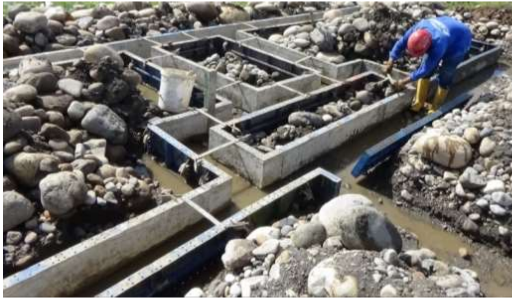
Fotografía 8. Encofrado de formaleta metálica de ciclópeos - Villa David etapa III
