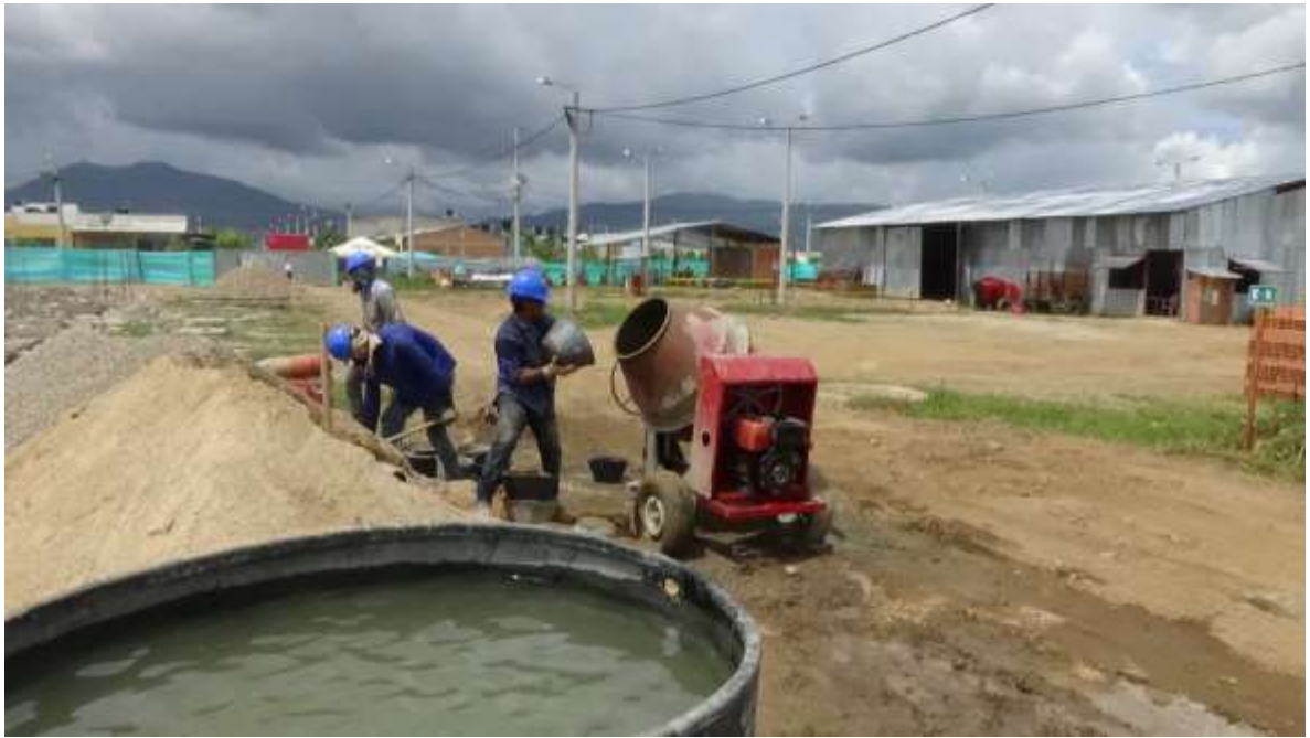
Fotografía 9. Concreto mesclado en obra de 3000 psi - Villa David etapa III.
