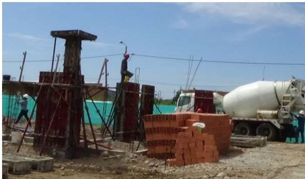
Fotografía 20. Fundición de muros confinados - Villa David etapa III
