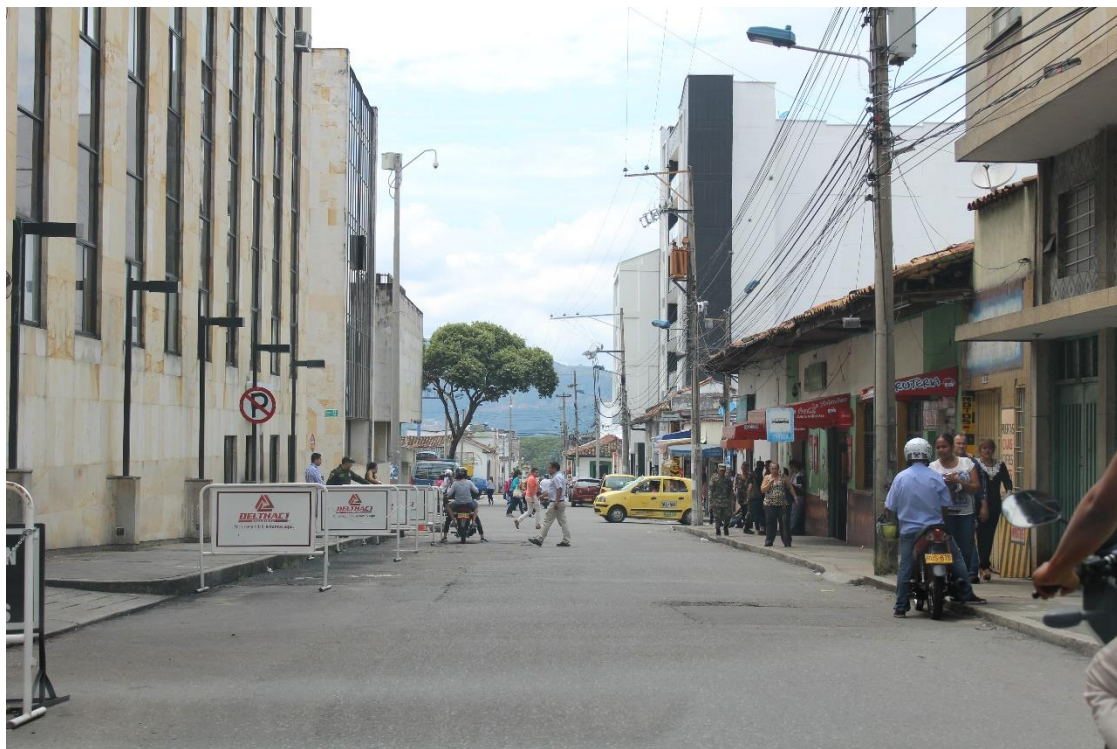
Figura 44, Estado Pavimento Calle 34.
