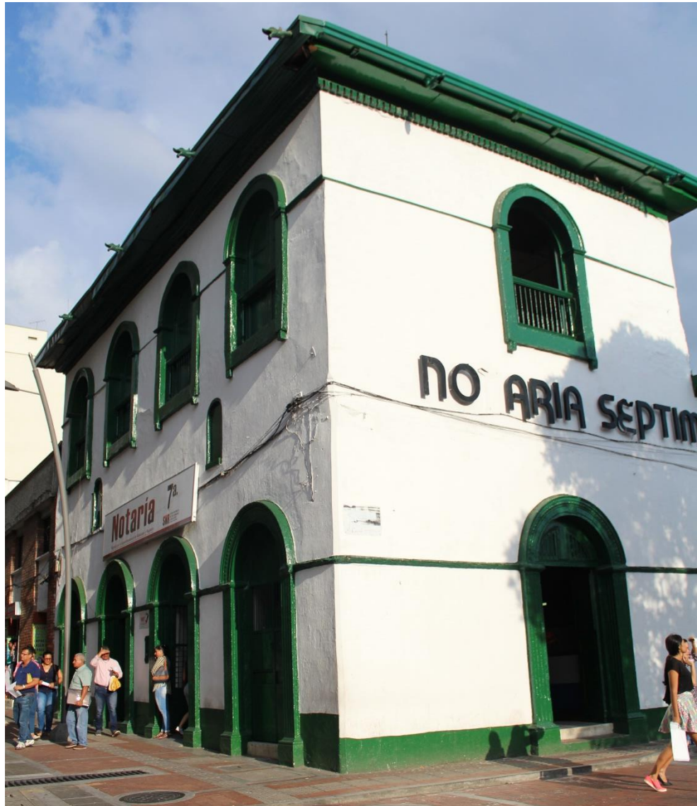
Figura 72, Edificio C.P. Clausen.
