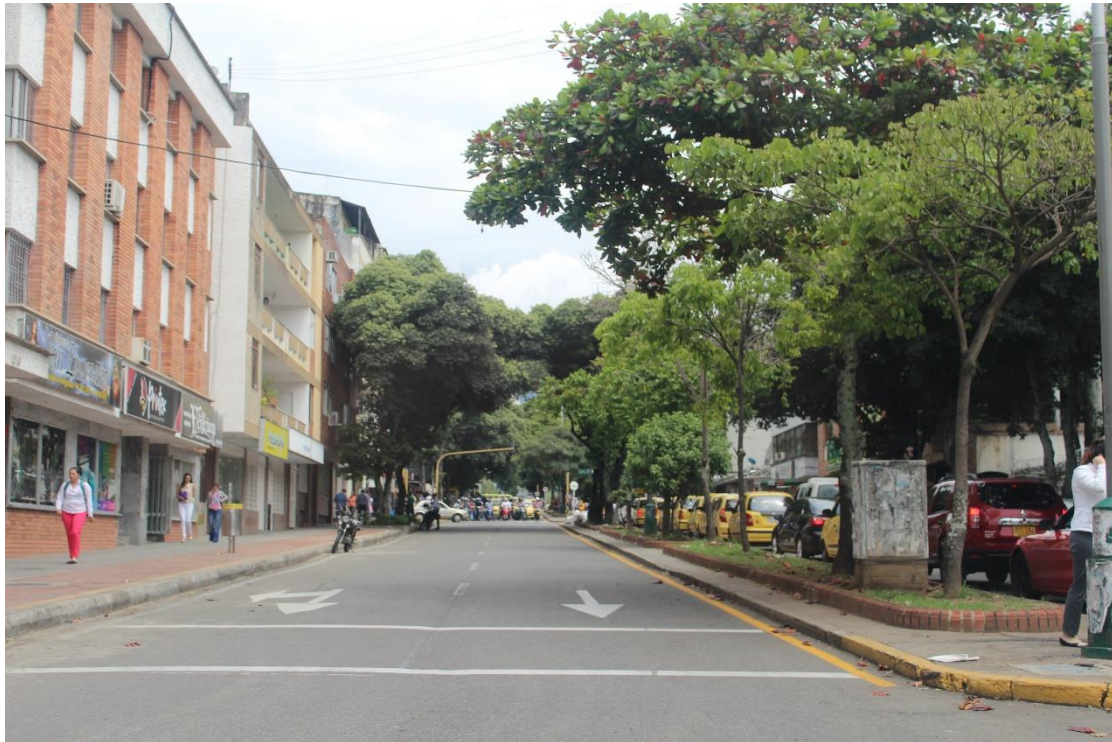
Figura 41, Estado Pavimento calle 36.
