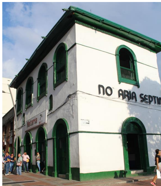
Figura 81, Fachada Nor-Occidental desde carrera 12.
