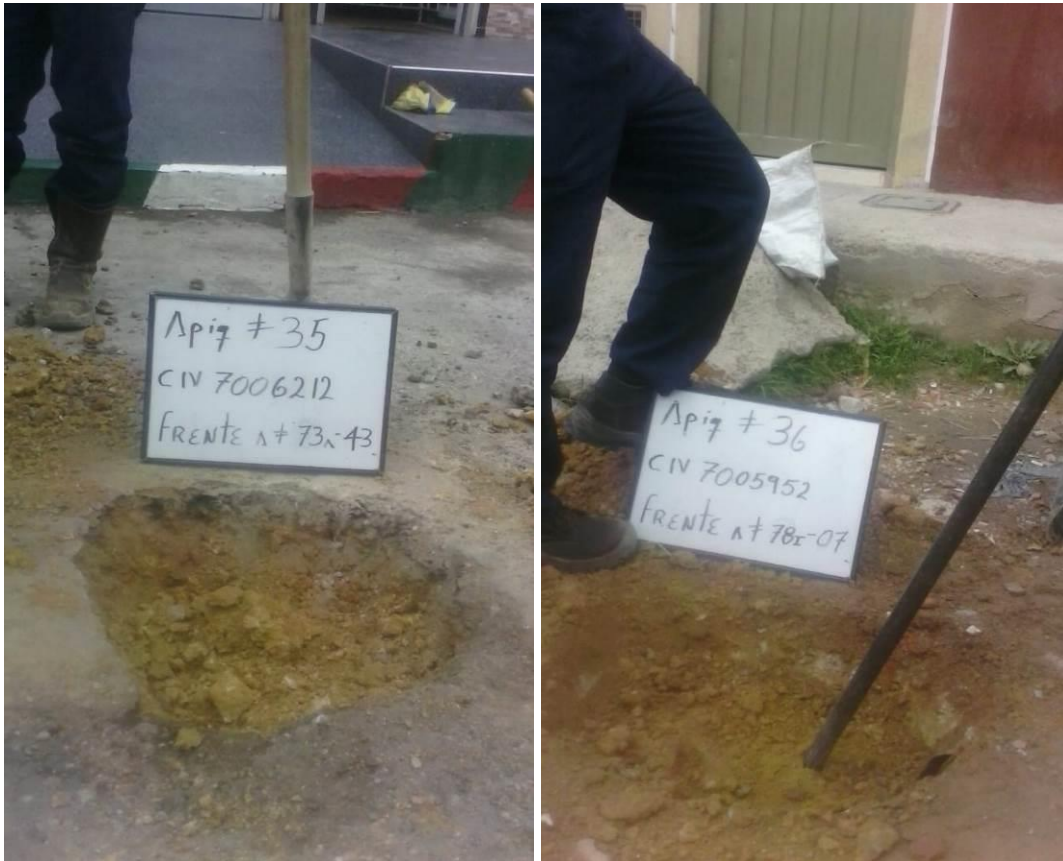
Figura 2. Registro fotográfico Apiques.
