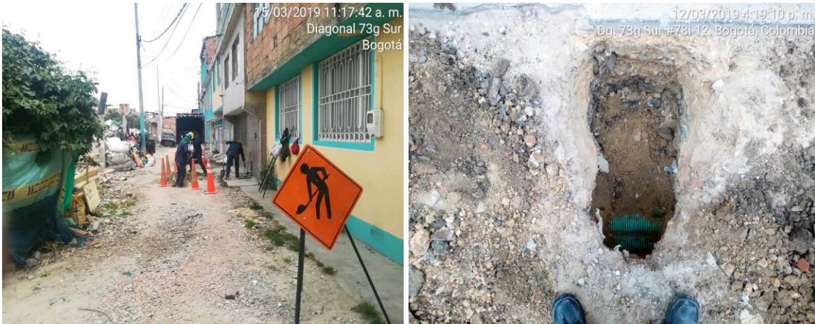
Figura 4. Registro fotográfico redes de gas
