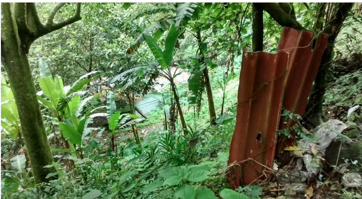
Imagen 2 Riesgo de precipicio en el sector 2, no hay barandas de seguridad y no se cuenta con señalización en la zona.
