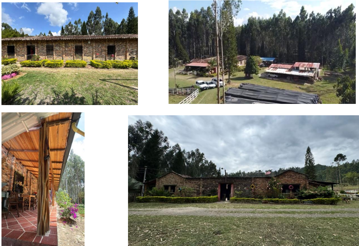
Figura 38. Fotos de la hacienda y la casa (Fachadas oeste, este y sur)
