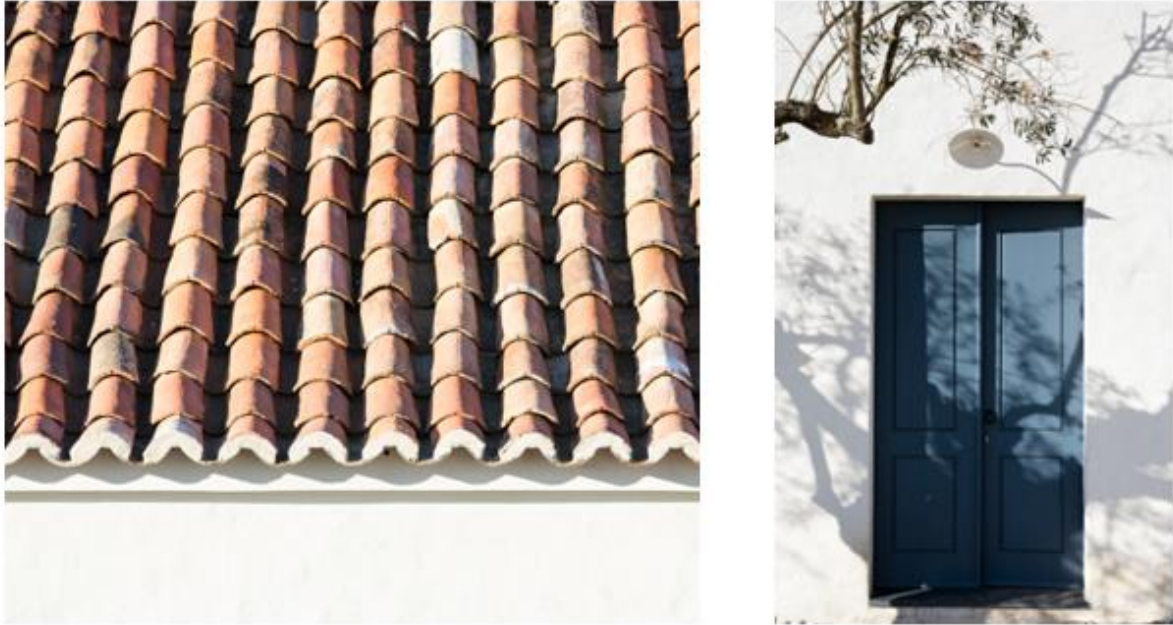
Figura 6. Fachadas y cubiertas
