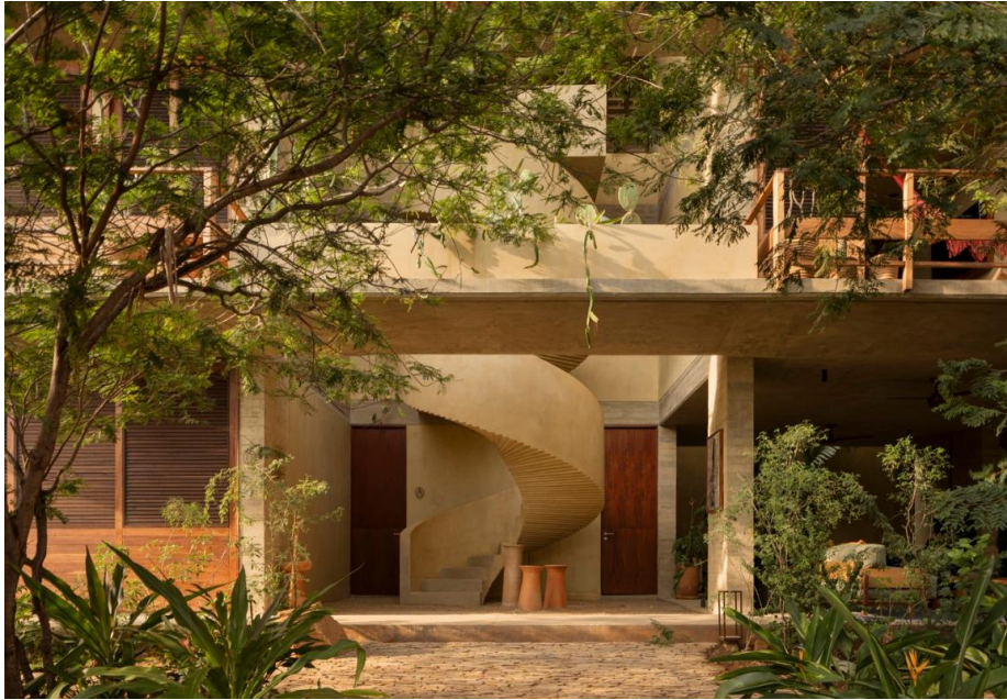
Figura 25. Punto fijo en el bloque de las habitaciones, ENNEA Hotel
