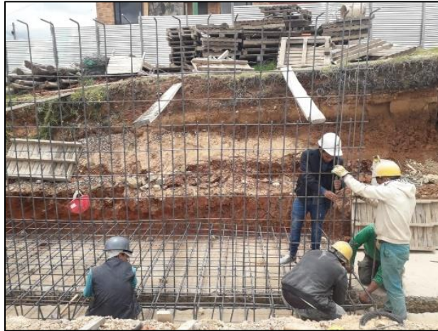
Ilustración 15- Amarre de acero zarpa muro de contención sección 3
