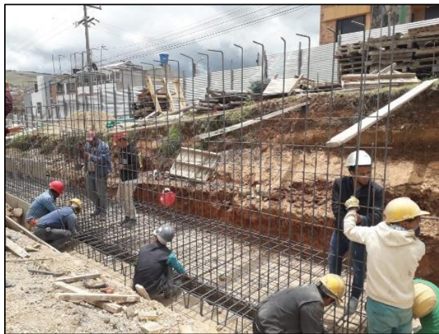
Ilustración 16- Amarre de acero cuerpo muro de contención sección 3
