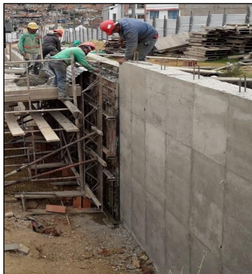
Ilustración 27- Muro de contención desencofrado
