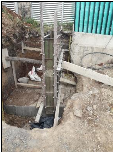
Ilustración 17- Encofrado muro de contención sección 8
