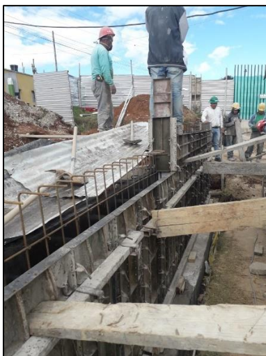
Ilustración 18- Encofrado muro de contención sección 6 y 7
