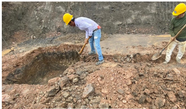
Figura 6: Excavación de vigas de cimentación y zapatas en el eje A
