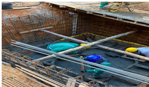
Figura 20: Fundida de solado de tanque de almacenamiento
