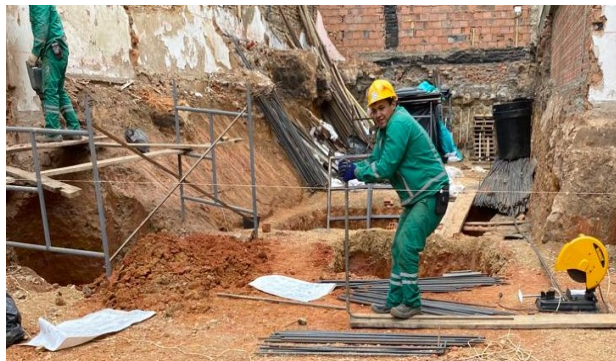
Figura 13: Figurado manual de acero
