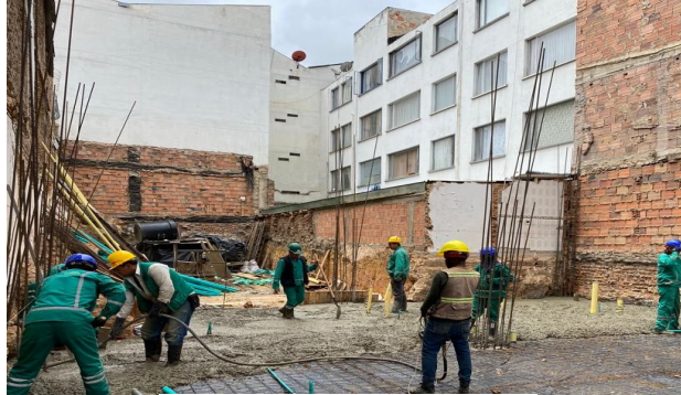
Figura 19: fundida losa de cimentación
