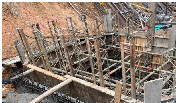
Figura 21: Fundida paredes tanque de almacenamiento
