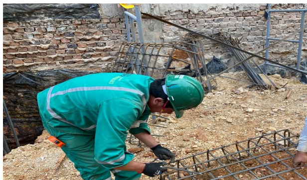
Figura 14: Amarre de parrilla zapatas
