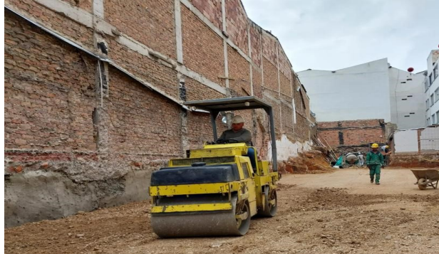
Figura 10: Compactación de material de afirmado
