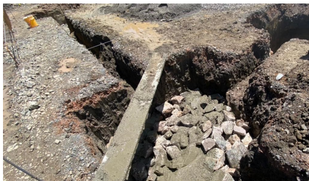
Figura 7: Fundida concreto ciclópeo eje A
