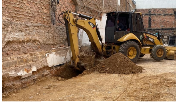
Figura 12: excavación de tubería sanitaria
