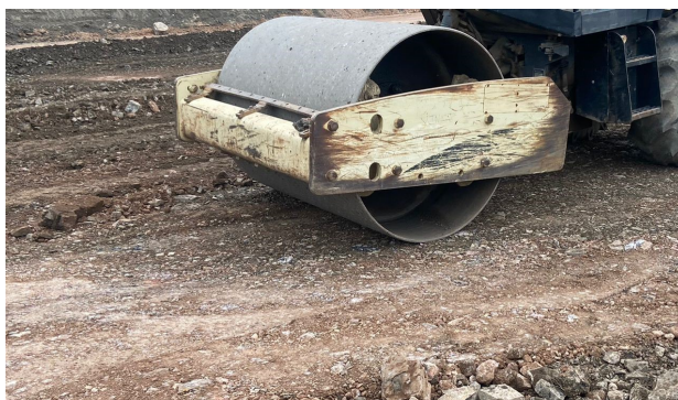
Figura 5: Compactación de material de afirmado
