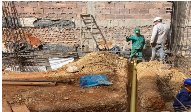
Figura 12: excavación de tubería sanitaria
