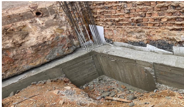
Figura 17: fundida de vigas de cimentación
