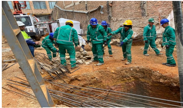
Figura 15: Fundida de concreto en las zapatas
