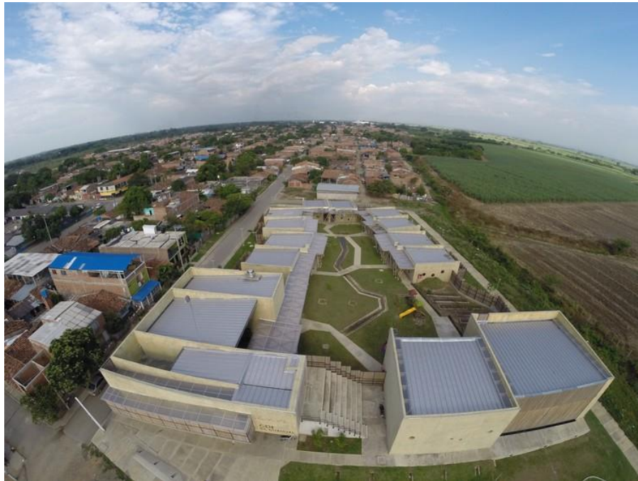
Figura 23. CDI el Guadual vista aérea fotografía. Iván Darío Quiñones.
