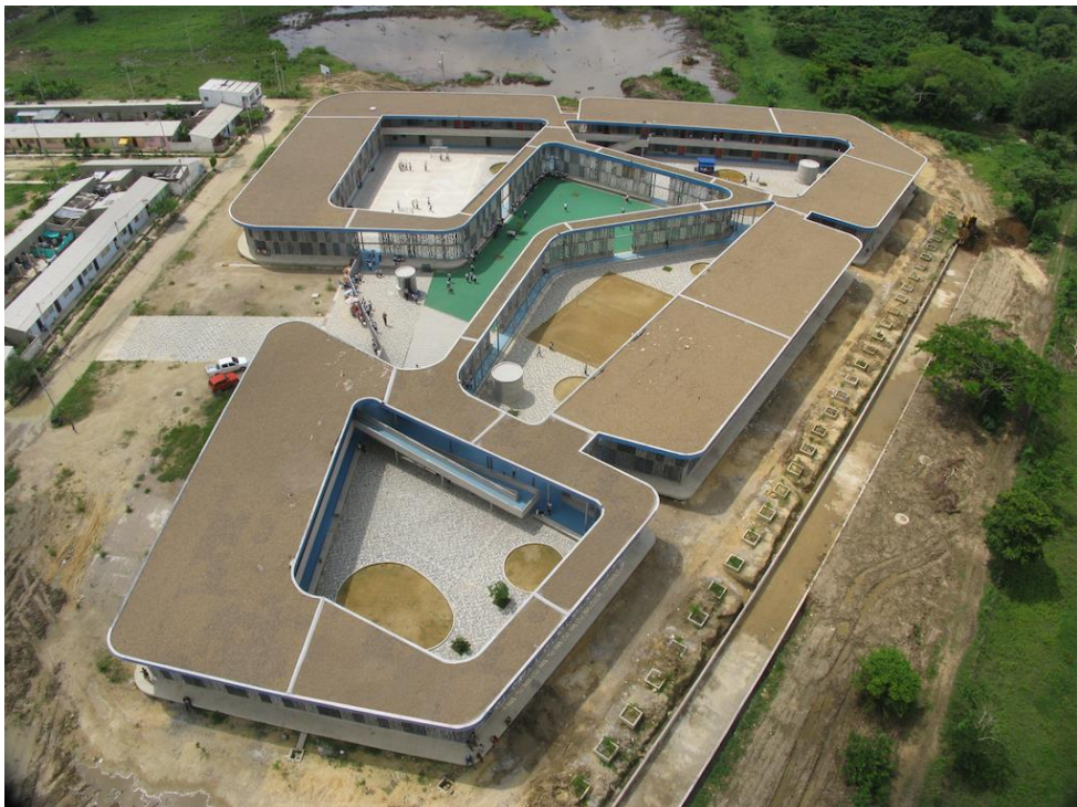
Figura 19. Institución Flor del campo Fuente: Plataforma de arquitectura
