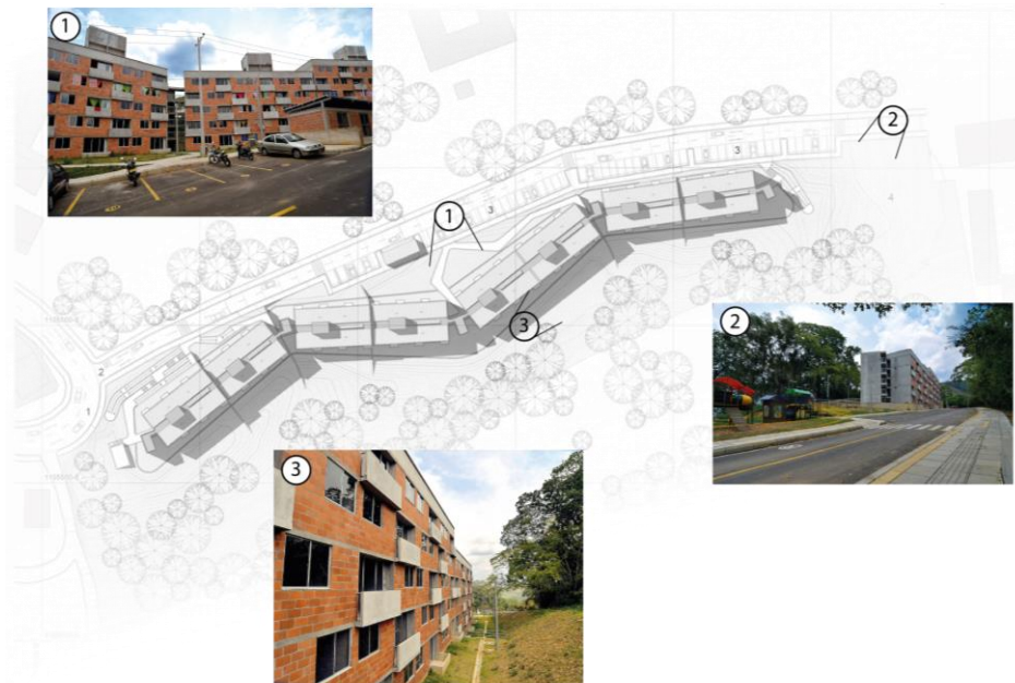
Figura 21. Equipamientos y espacios verdes conjunto Norte Club
