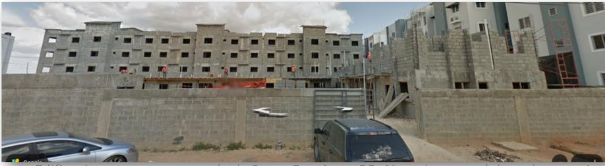
Edificaciones en mampostería de Santo Domingo, RD. Nota. Imagen elaborada a partir de Google Earth (Google, 2026).
