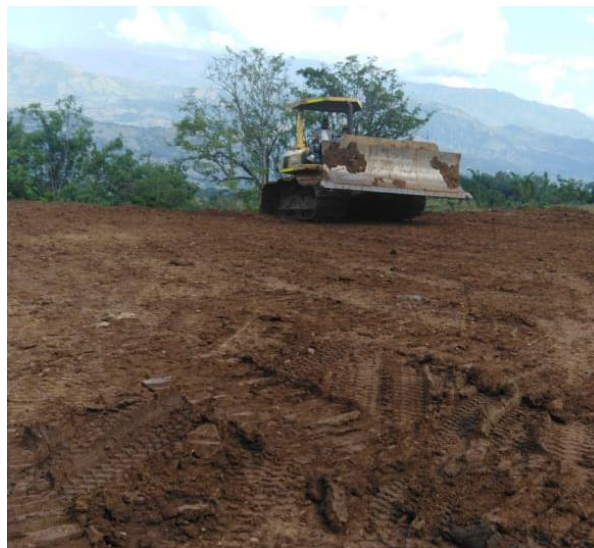
Ilustración 10 Descapote y relleno del zodme
