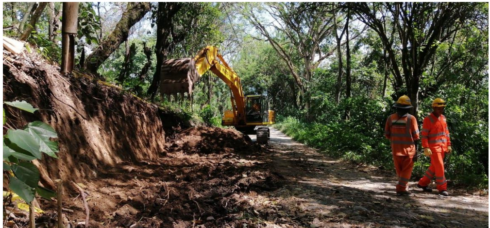
Ilustración 2 Intervencion de vía - Abcisa 7+400
