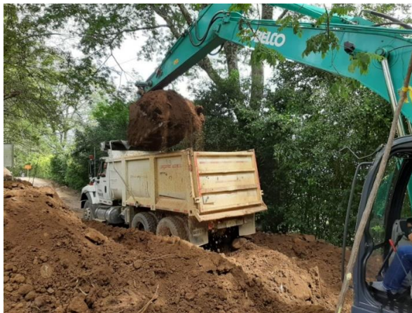
Ilustración 13 Seleccionando material de excavación en la abscisa 6km+450 Fecha: 05 de diciembre de 2019
