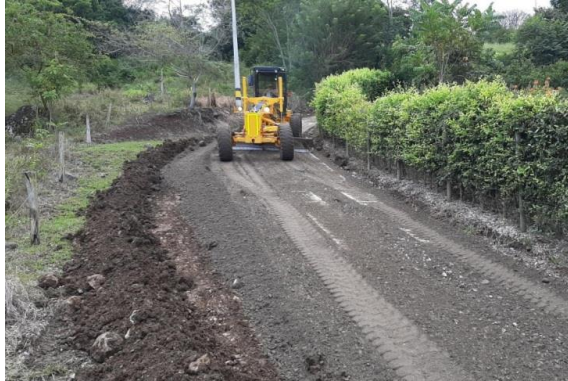
Ilustración 11 Mejoramiento entrada al zodme Fecha: 03 de diciembre de 2019
