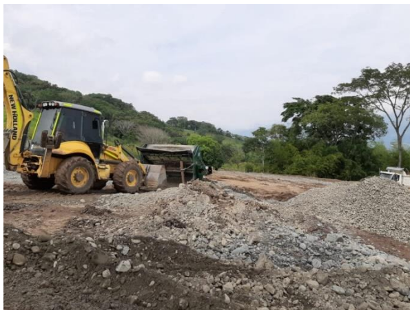
Ilustración 5 Control de Material
