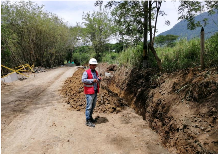
Ilustración 9 Control de la excavación para los filtros longitudinales
