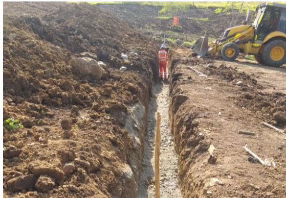
Ilustración 12 Excavación para filtros en el zodme Fecha: 03 de diciembre de 2019
