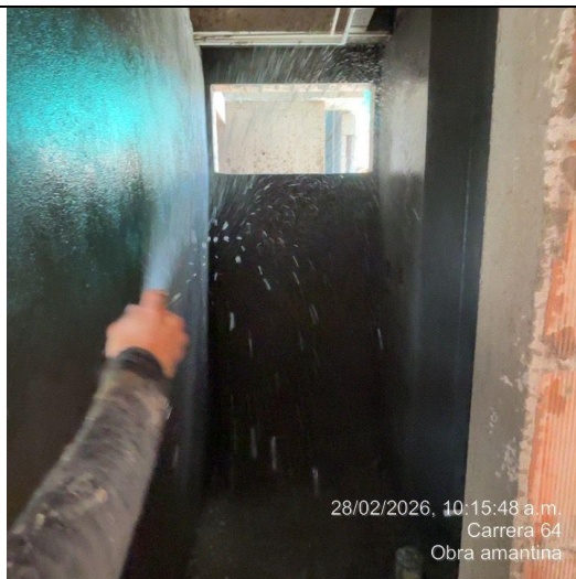
Curado de morteros de revoques
