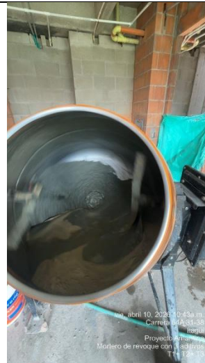
Consistencia de la mezcla Mortero T1+T2+T3
