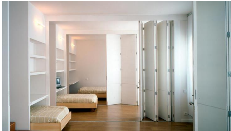
Figura 17. Viviendas en Carabanchel con tabiques móviles.
