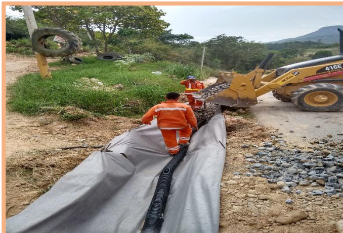
FOTO 2: Construcción filtros SECTOR 1, K0 +030 al K0+540.
