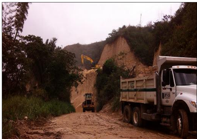
FOTO 1: Explanación y corte de talud para ampliación de banca, SECTOR 2.
