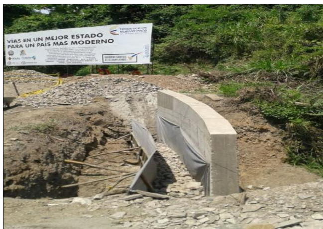
FOTO 6: Construcción de filtro, muro K 24+646.
