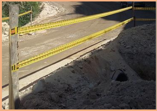
FOTO 3: Instalación de 9 tubos Alcantarilla, SECTOR 2
