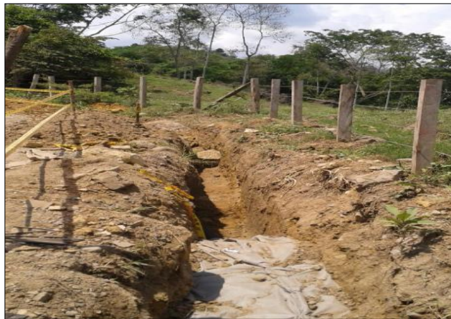
FOTO 4: Excavación, construcción filtro K 24+900.
