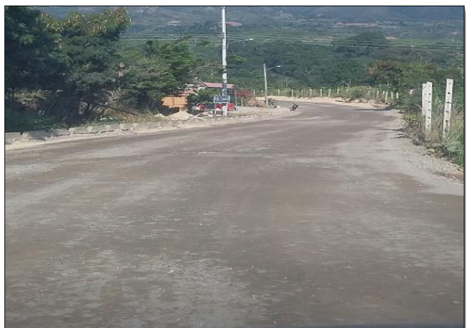
FOTO 3: Instalación Sub base y Base SECTOR 1
