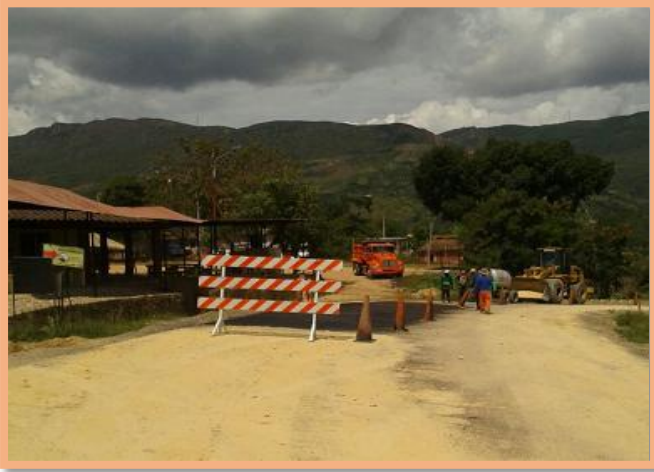
FOTO 1: Aplicación emulsión asfáltica, SECTOR 1.
