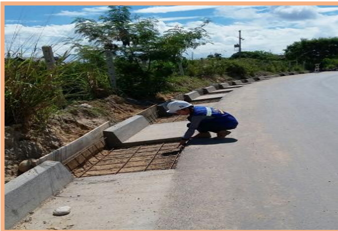
FOTO 1: Construcción cunetas SECTOR 1, K0 +030 al K0+540.
