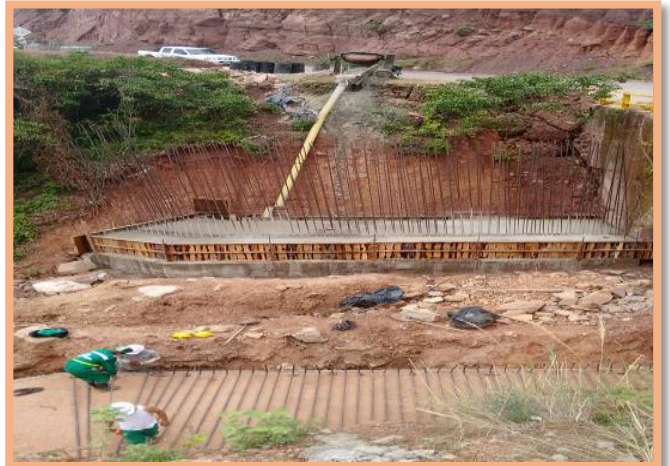
FOTO 6: Construcción zarpa costado derecho, Puente K
