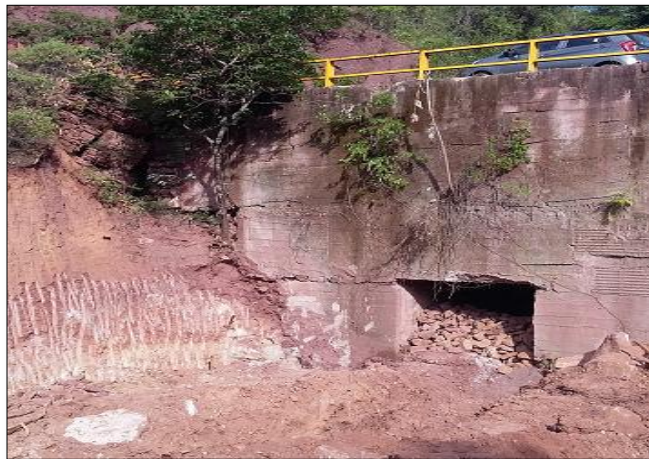
FOTO 6: Excavación cimientos Puente K12+600.
