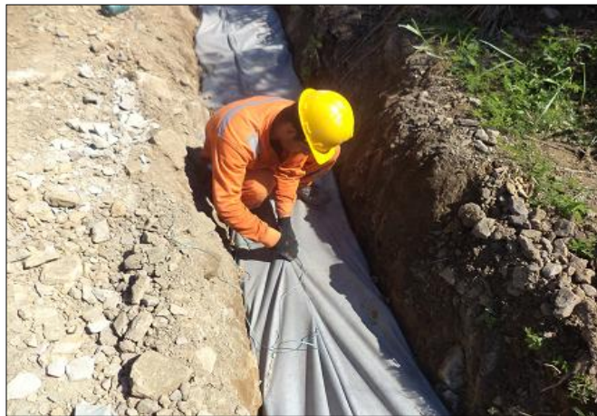
FOTO 4: Excavación, construcción filtro K 24+300.
