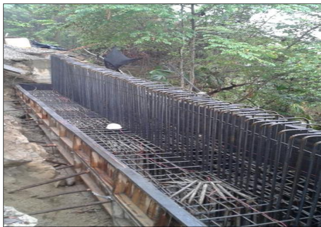
FOTO 2: Acero viga cabezal y elevación muro, modulo 8 K 27+500.
