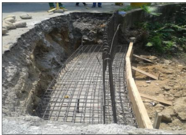
FOTO 2: Figurado y armado de acero de refuerzo de zarpa y elevación muro K 26+950.
