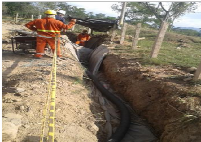
FOTO 4: Excavación, construcción filtro K 25+100.
