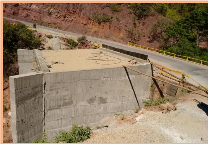
FOTO 6: Construcción placa, puente K 12+600.
