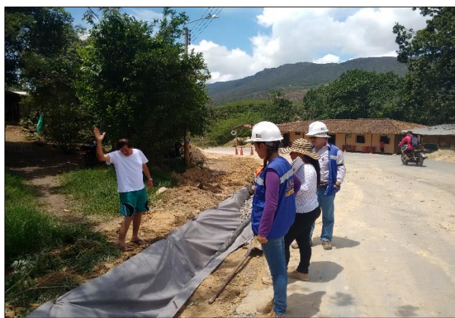
FOTO 2: Construcción filtros SECTOR 1, K0 +030 al K0+540.
