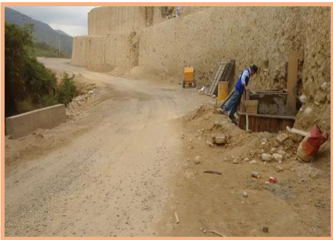
FOTO 3: Construcción alcantarilla, K 4+380 SECTOR 2
