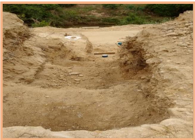
FOTO 5: Excavación para construcción disipadores de energía, SECTOR 2 K 4+400.
