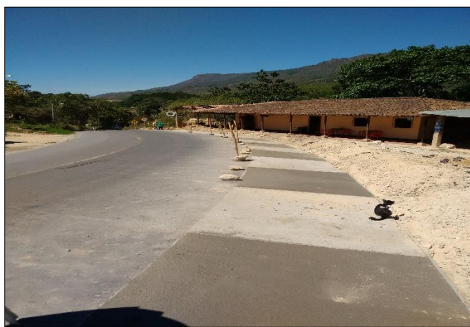
FOTO 1: Construcción cunetas SECTOR 1, K0 +030 al K0+540.
