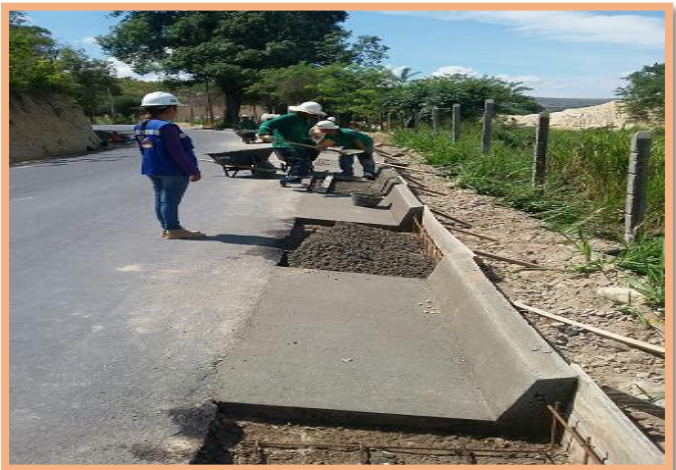
FOTO 3: Construcción cunetas SECTOR 2, K4 + 150 al K4 + 610.
