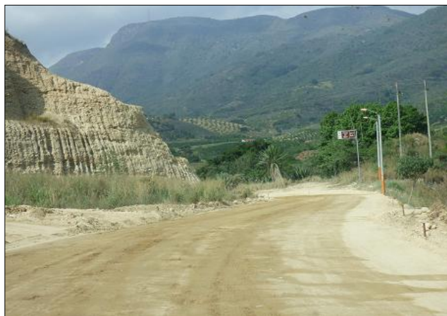
FOTO 2: Limpieza de la vía para nivelar subrasante, SECTOR 2
