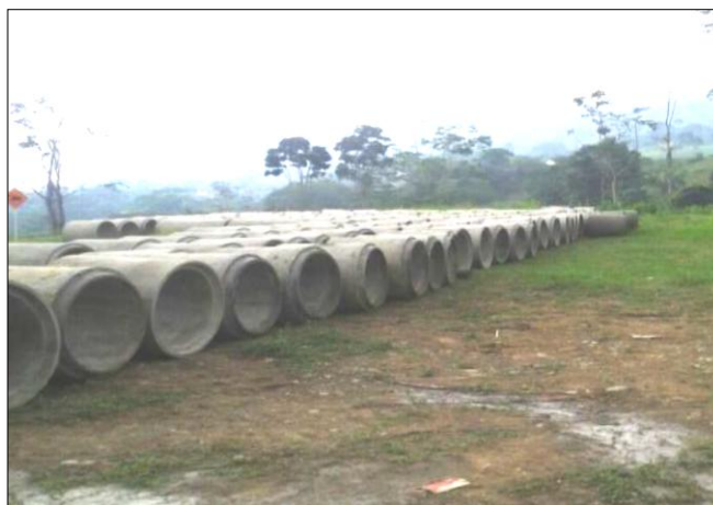
FOTO 6: Construcción tubería de 36" Alcantarilla de 36".
