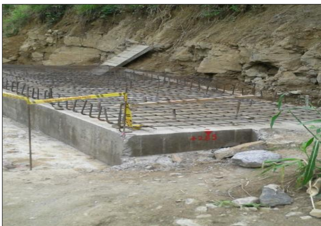
FOTO 5: Construcción zarpa muro 26+600.
