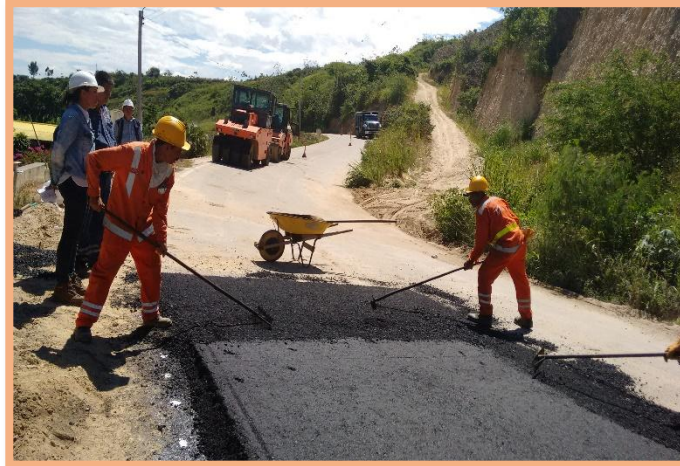
FOTO 2: Pavimentación SECTOR 2, K4 + 150 al K4 + 610.
