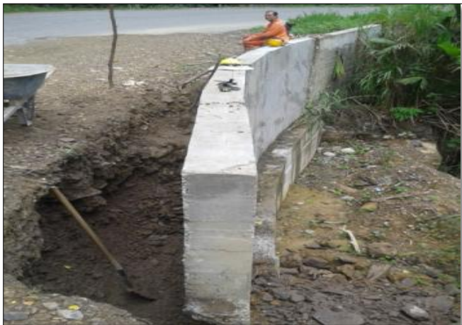
FOTO 3: Construcción de filtro, muro K 26+800.
