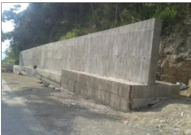
FOTO 5: Construcción elevación Muro Alcancía K 26+600.
