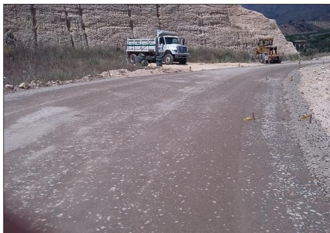
FOTO 4: Instalación Sub base y Base, SECTOR 2
