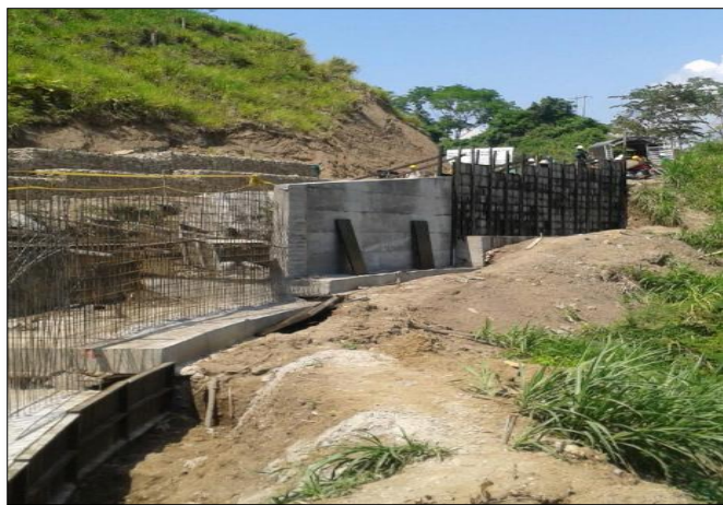
FOTO 1: Formateado de elevación de muro, módulo 4 K 24+500.
