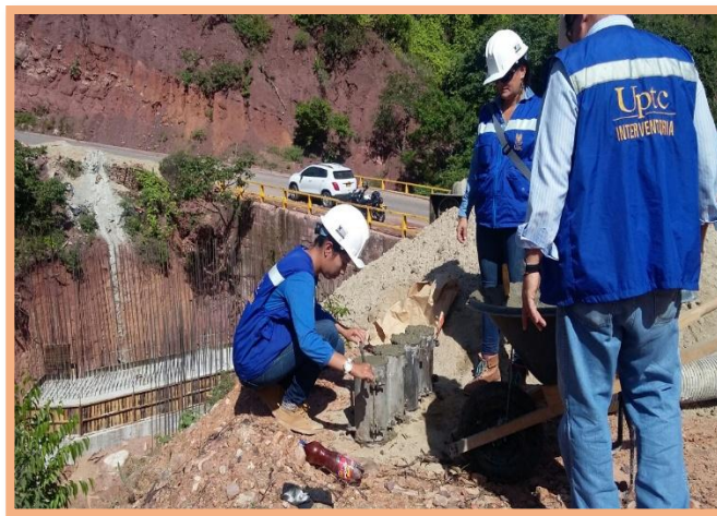
FOTO 6: Toma de cilindros de concreto, elevación muro, puente K 12+600.
