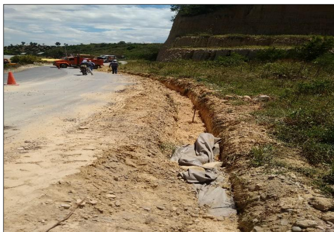
FOTO 2: Construcción filtros SECTOR 1, K0 +030 al K0+540.
