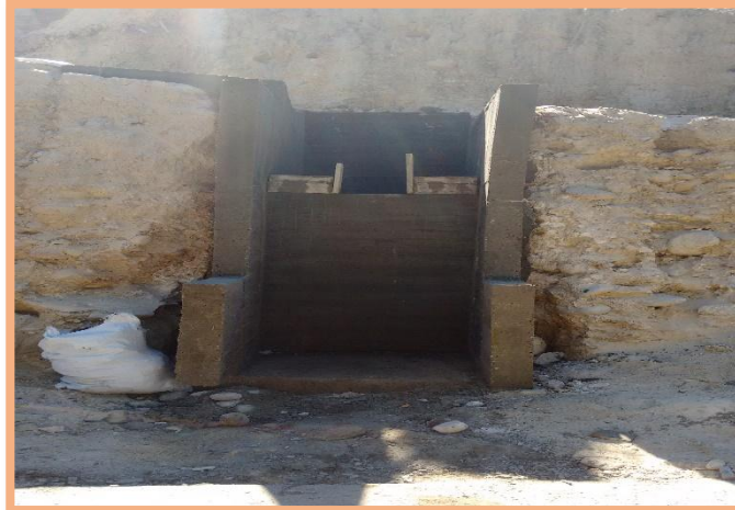
FOTO 4: Construcción dissipador, K 4+400 SECTOR 2.
