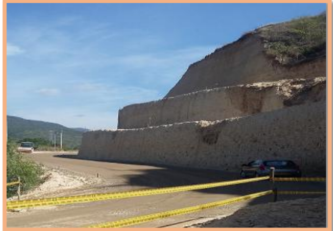
FOTO 4: Conformación de Terrazas, SECTOR 2.
