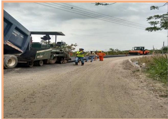
FOTO 2: Pavimentación SECTOR 1, K0 + 030 al K0 + 540.
