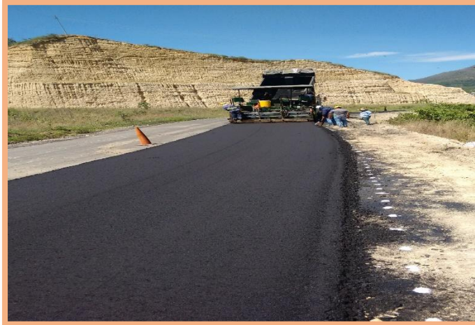
FOTO 1: Pavimentación SECTOR 2, K4 + 150 al K4 + 610.
