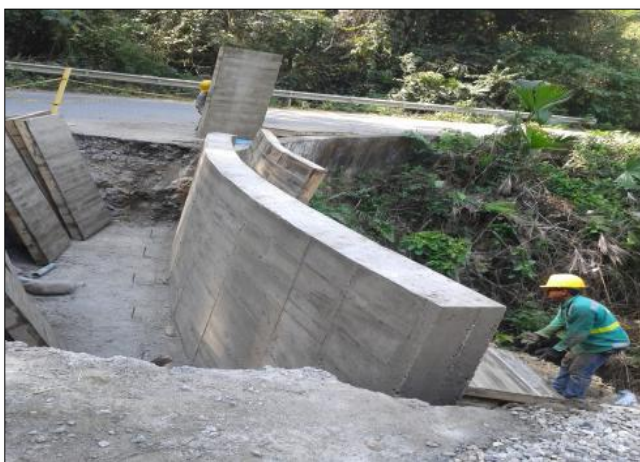
FOTO 1: Cimentación profunda para construcción muro K 27+250.
