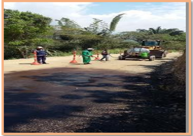
FOTO 2: Aplicación emulsión asfáltica, SECTOR 2
