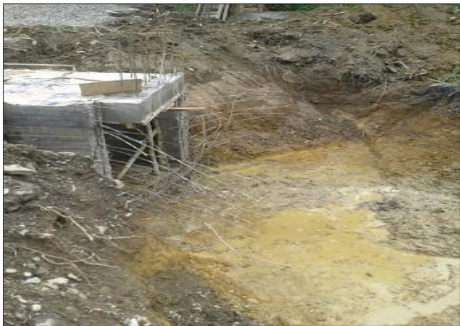
FOTO 3: Construcción Box Culvert K 25+742.
