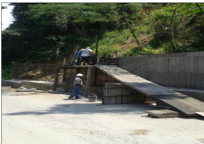
FOTO 5: Construcción zarpa muro 26+600.
