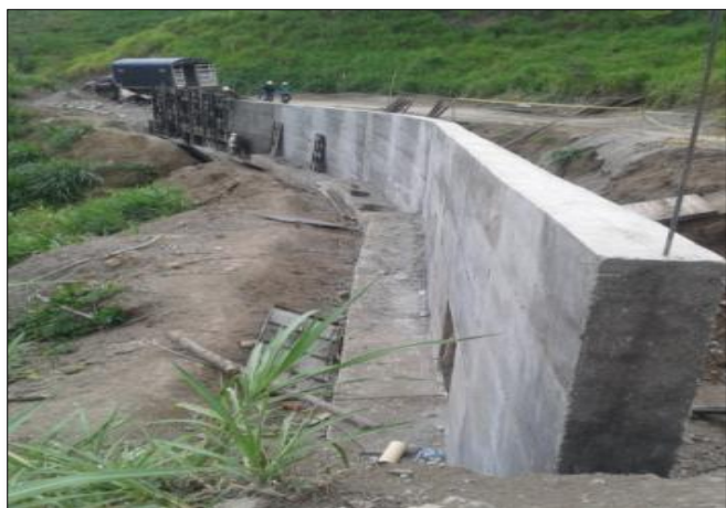
FOTO 1: Muro de Contención K 24+500.
