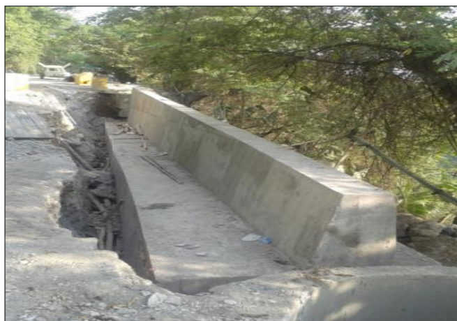
FOTO 2: Viga cabezal y elevación muro, modulo 8 K 27+500.
