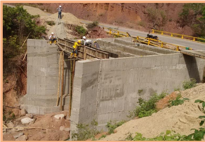
FOTO 5: Armado de acero formateado para la fundida 4 vigas y riostra, puente K 12+600.
