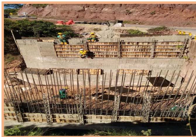
FOTO 6: Construcción elevación muro costado derecho, puente K 12+600.
