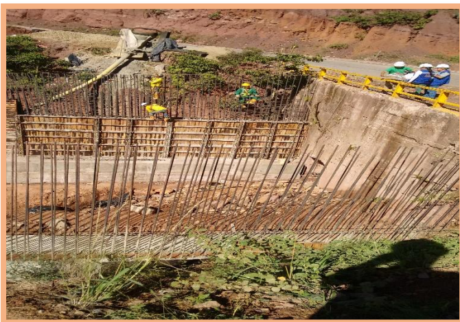
FOTO 5: Formateado para la fundición primera sección de elevación muro, puente K 12+600.
