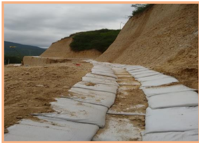
FOTO 4: Zanjas de coronación en las Terrazas, SECTOR 2.
