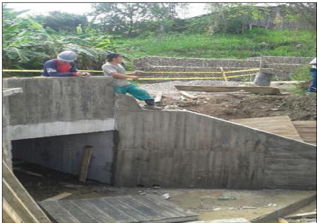
FOTO 3: Construcción Box Culvert K 25+742.
