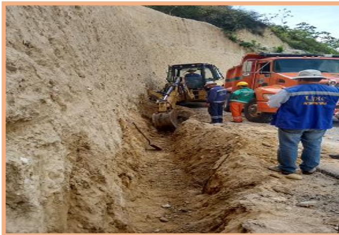
FOTO 4: Construcción filtros SECTOR 2, K4 + 150 al K4 + 610.
