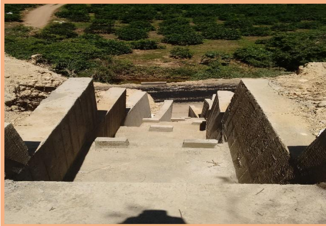
FOTO 3: Construcción dissipador, K 4+380 SECTOR 2
