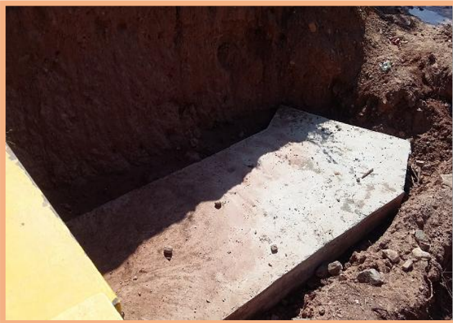
FOTO 5: Mejoramiento en concreto ciclópe para la
