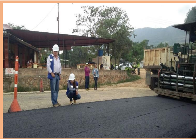
FOTO 1: Pavimentación SECTOR 1, K0 + 030 al K0 + 540.
