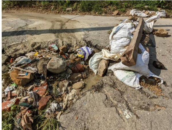
Figura 11. Arreglo improvisado por habitantes del sector
