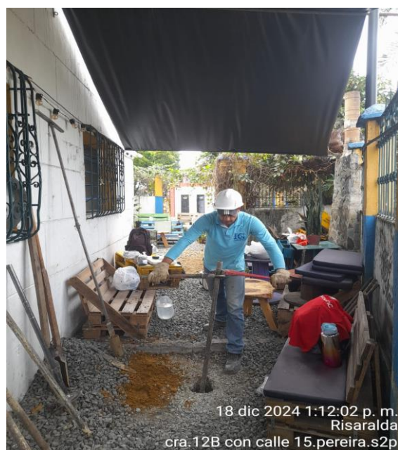
Figura No 4 Ejecución de Sondeos S2
