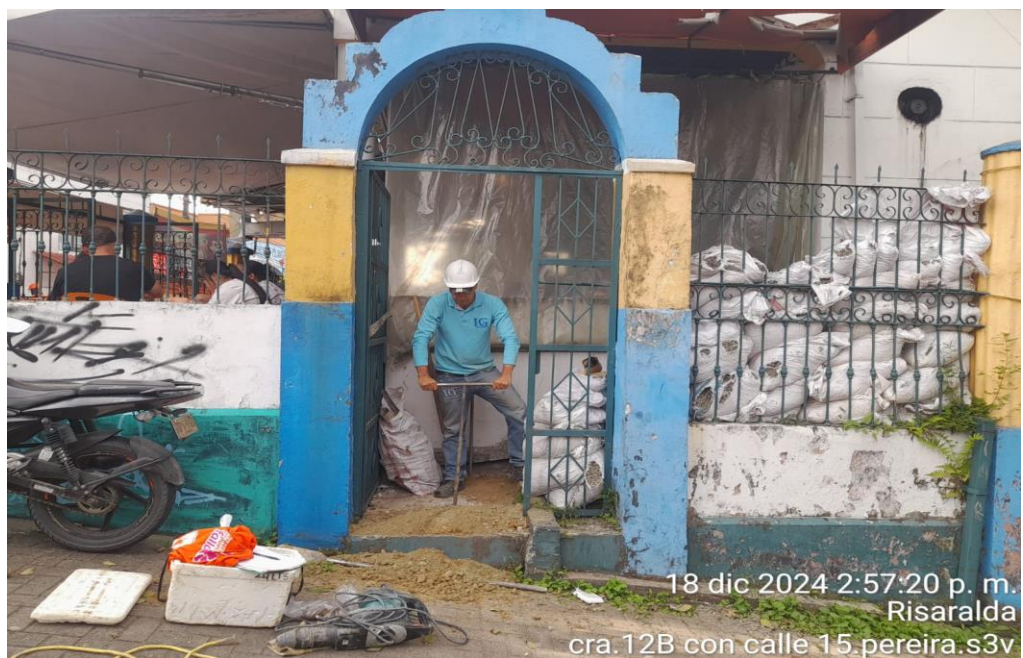
Figura No 3 Ejecución de Sondeos S3
