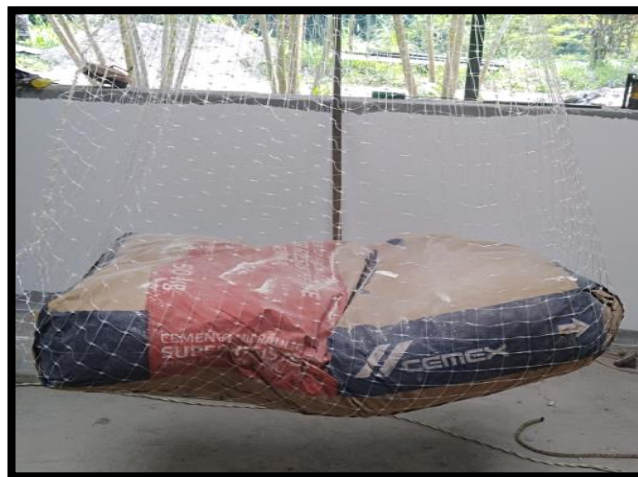
Imagen 10.21: Prueba de carga malla industrial plástica. Fuente 74: Autor.
