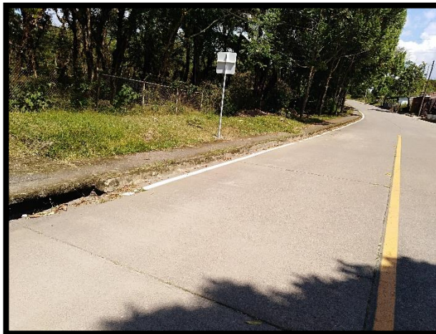
Imagen 9.4: Pendiente proveniente de la parte sur de la inspección de Mámbita. Fuente 17: Autor.
