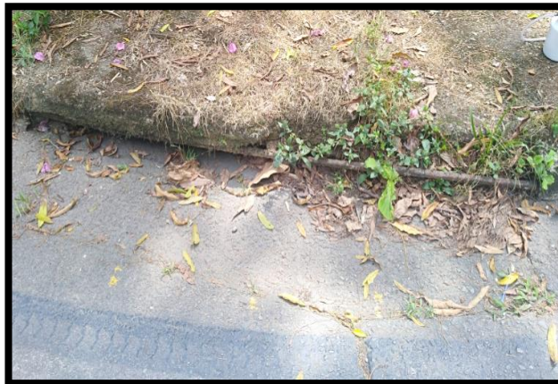
Imagen 9.2: Sumidero lateral parte media de la zona baja de la inspección. Fuente 15: Autor.
