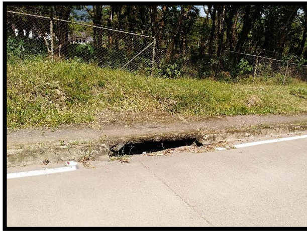
Imagen 9.3: Sumidero posiblemente apto para colocación de la malla. Fuente 16: Autor.
