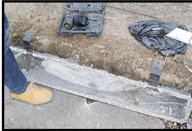
Imagen 11.4: Acoplamiento de prototipo en el sumidero escogido. Fuente 79: Autor.
