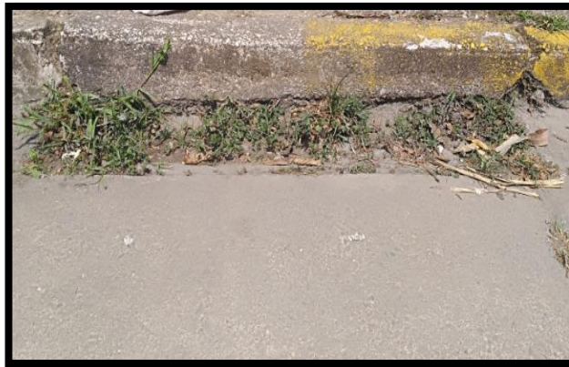
Imagen 9.1: Sumidero lateral de la parte superior de la zona baja de la inspección. Fuente 14: Autor.
