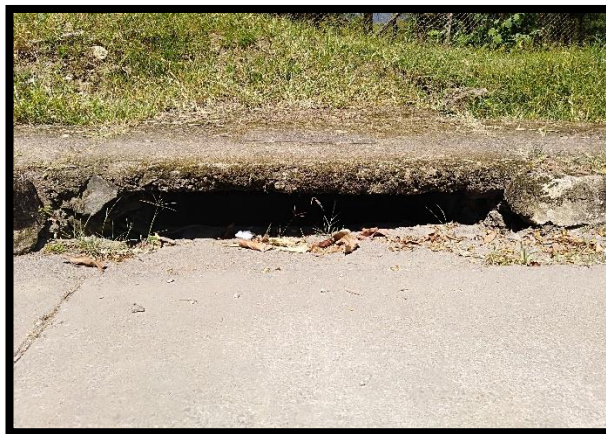
Imagen 11.1: Características físicas de la boca del sumidero. Fuente 76: Autor.
