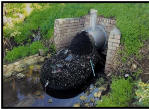
Imagen 7.5: Redes de drenaje para reducir la descarga de basura en la naturaleza en Australia. Fuente 10: Storm Water Systems.
