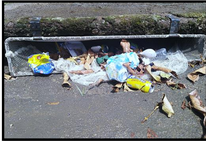
Imagen 11.8: Basura recogida por el sistema de malla recaudadora de residuos sólidos. Fuente 83: Autor.
