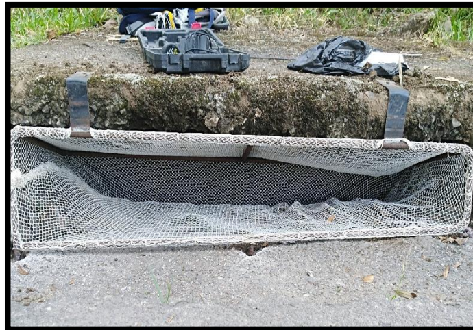
Imagen 11.5: Montaje completo en sumidero escogido. Fuente 80: Autor.
