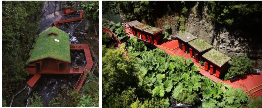
Figura 48. Vistas exteriores de la cubierta verde
