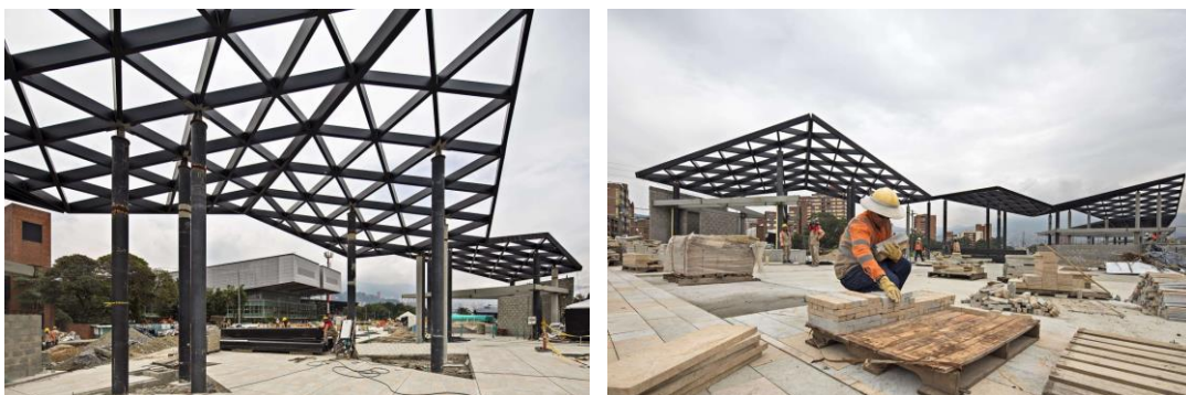
Figura 29. Proceso de construcción del proyecto
